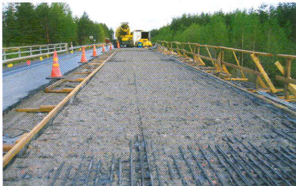
Kukkopuron ylikulkusillan kannen vesipiikattua yläpintaa.
