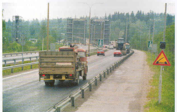
Päivärannan läppäsilta avattuna.
