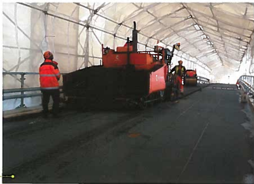
Kannen suoja-asfaltin levittäminen käynnissä sääsuojan sisällä tammikuussa 2015.
