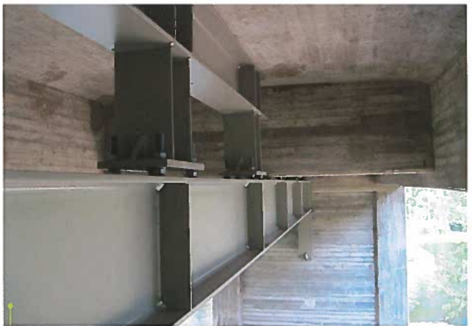
Kannen Teräsvahvistus asennettuna sillan kannen alle.
