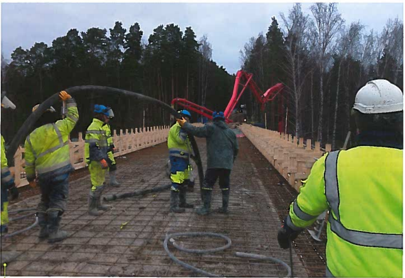
Sillan kannen muotoiluvälu ja ulokkeen betonointityö käynnissä.
