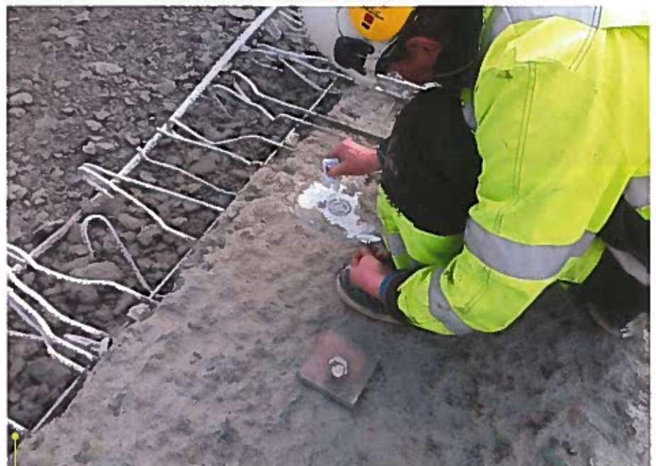
Vesipiikatin sillan kannen tartuntavetolujuuden mittaaminen käynnissä. Mittaaja Koskelainen Timo.
