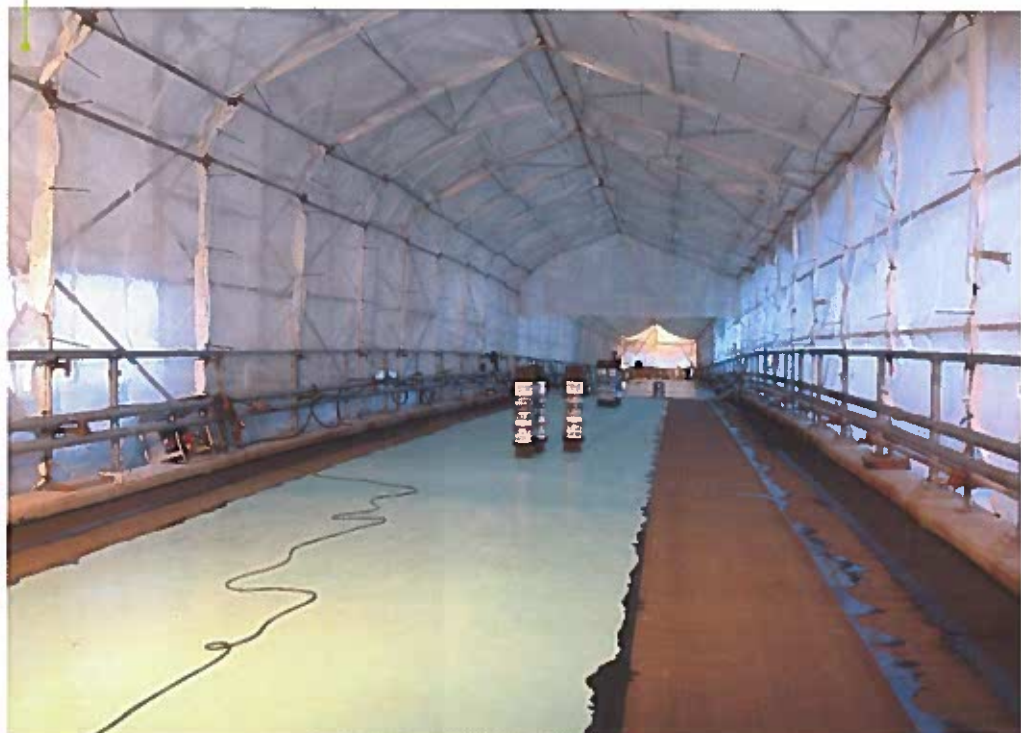
Kannen pohjakermityö käynnissä epoksiivistyksen päälle.
