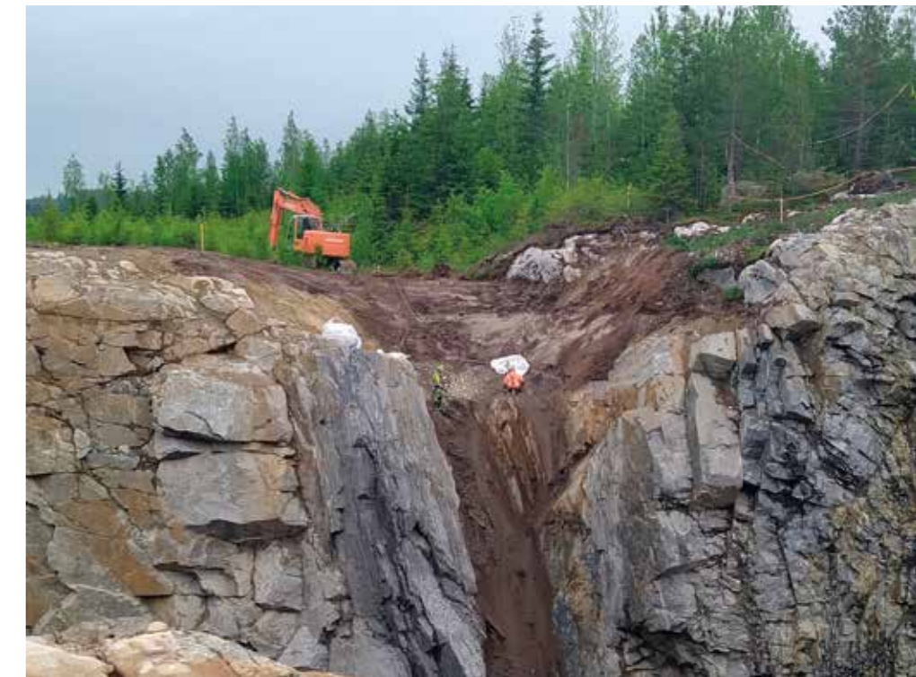
Kallioleikkauksen irtolohkareiden rusnaaminen käsityönä käynnissä turvavaljaiden kanssa.
