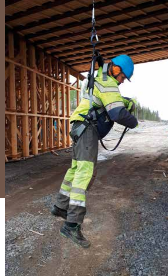
Kirvesmies testaa turvavaljaiden toimivuutta vt5 Mikkeli - Nuutilanmäki projektilla.
