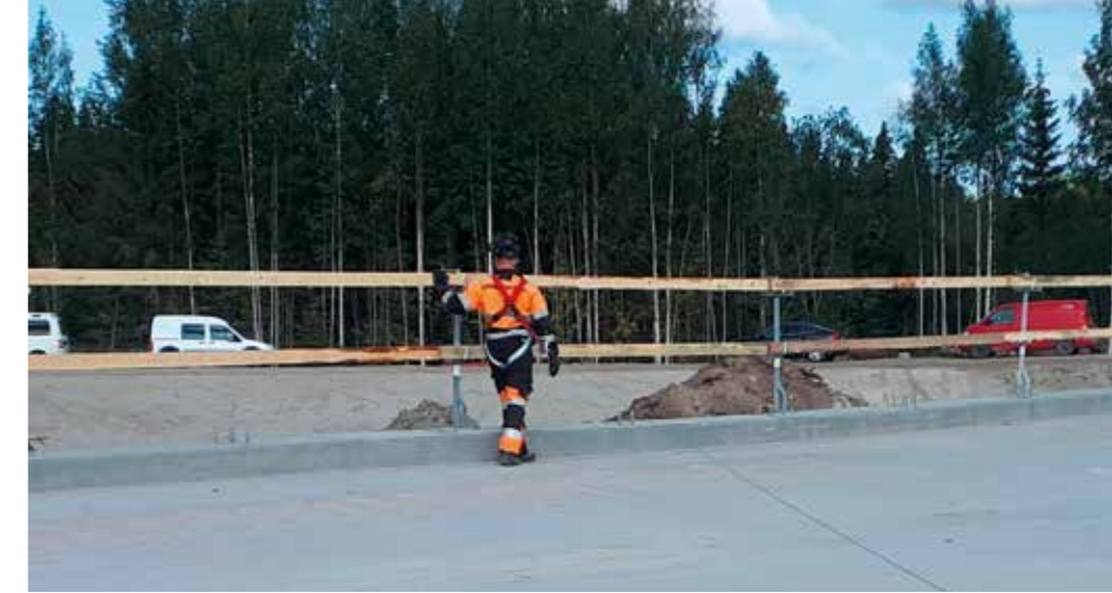
Turvakaiteen asentaminen putoamissuojaksi käynnissä vt5 Mikkeli - Nuutilanmäki projektilla.
