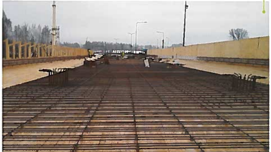
Ristiinantien pohjoisen risteyssillan (S6) kannen raudoitustyö käynnissä.
