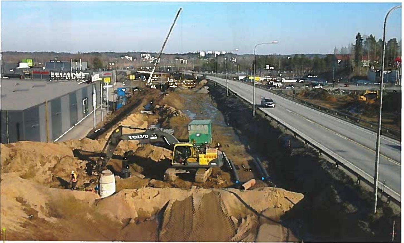
Putkitustyöt ja kaivojen asennus käynnissä vt 5 vasemmalle ajoradalle lähellä Sammonkatua.
