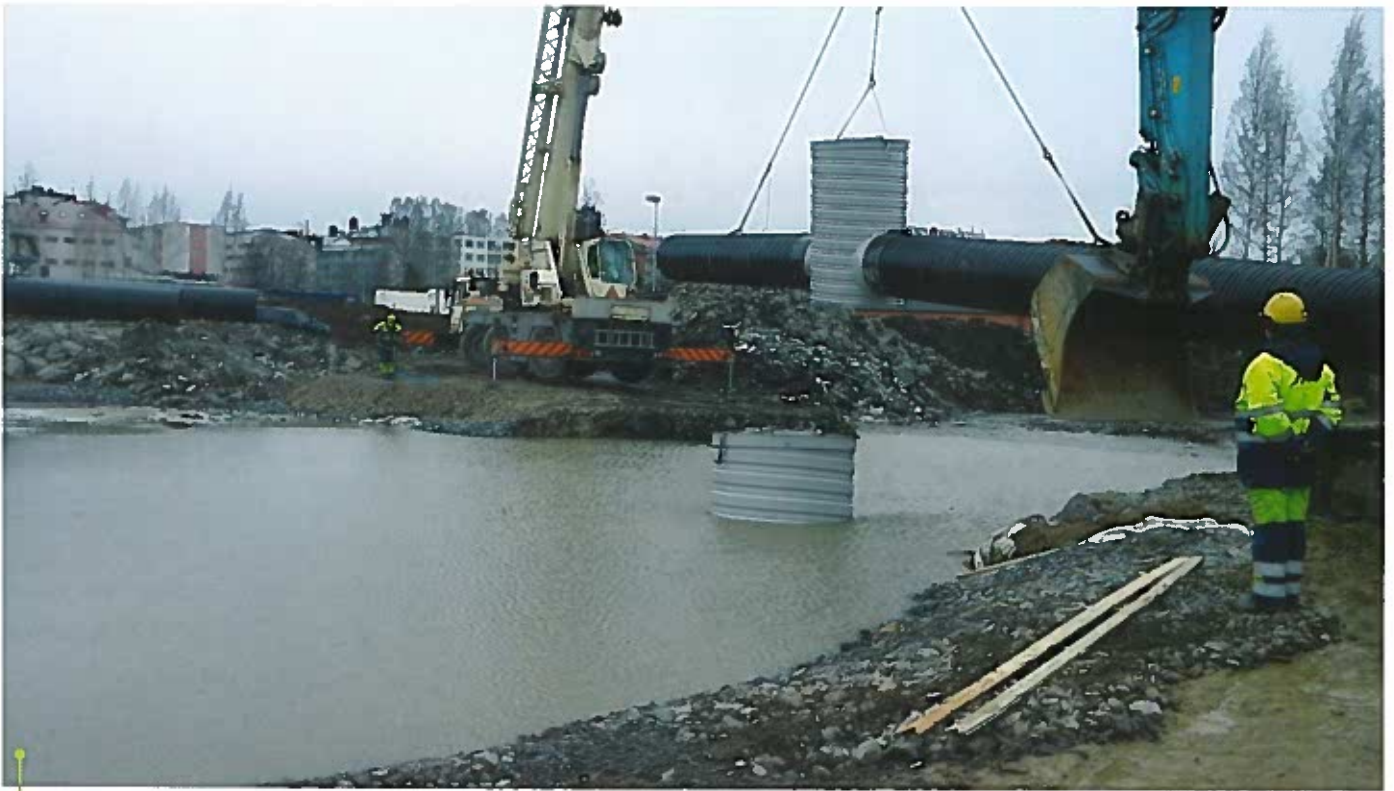
Selkeytsaltaan sulkukaivojen ja putkistojen asentaminen.
