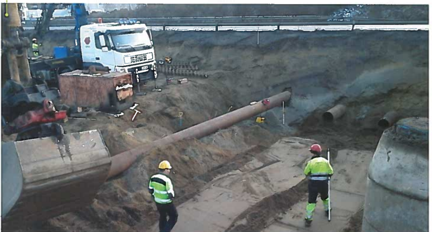
Teräksisten suojaputkien tunkkaus valtatie 5 ali käynnissä.
