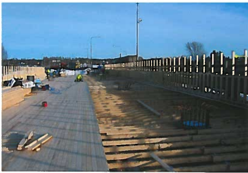
Ristiinantien pohjoisen risteyssillan (S6) kannen muottilaudoitusta.
