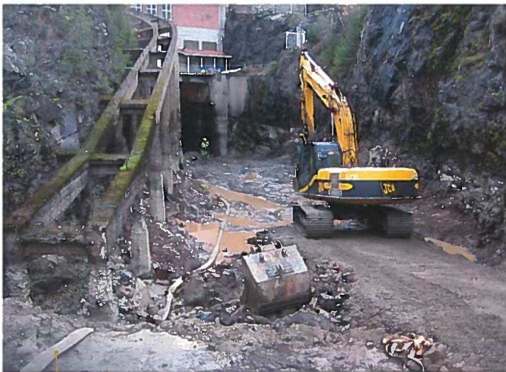
Imuputken seinien ja settiurien korjaamista työpadon sisällä.
