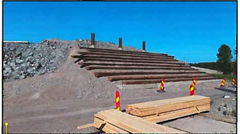
Valokuva siltojen telineiden pohjasta, joka on esitetty poikkileikkauksenäkymänä kuvassa 4a.
