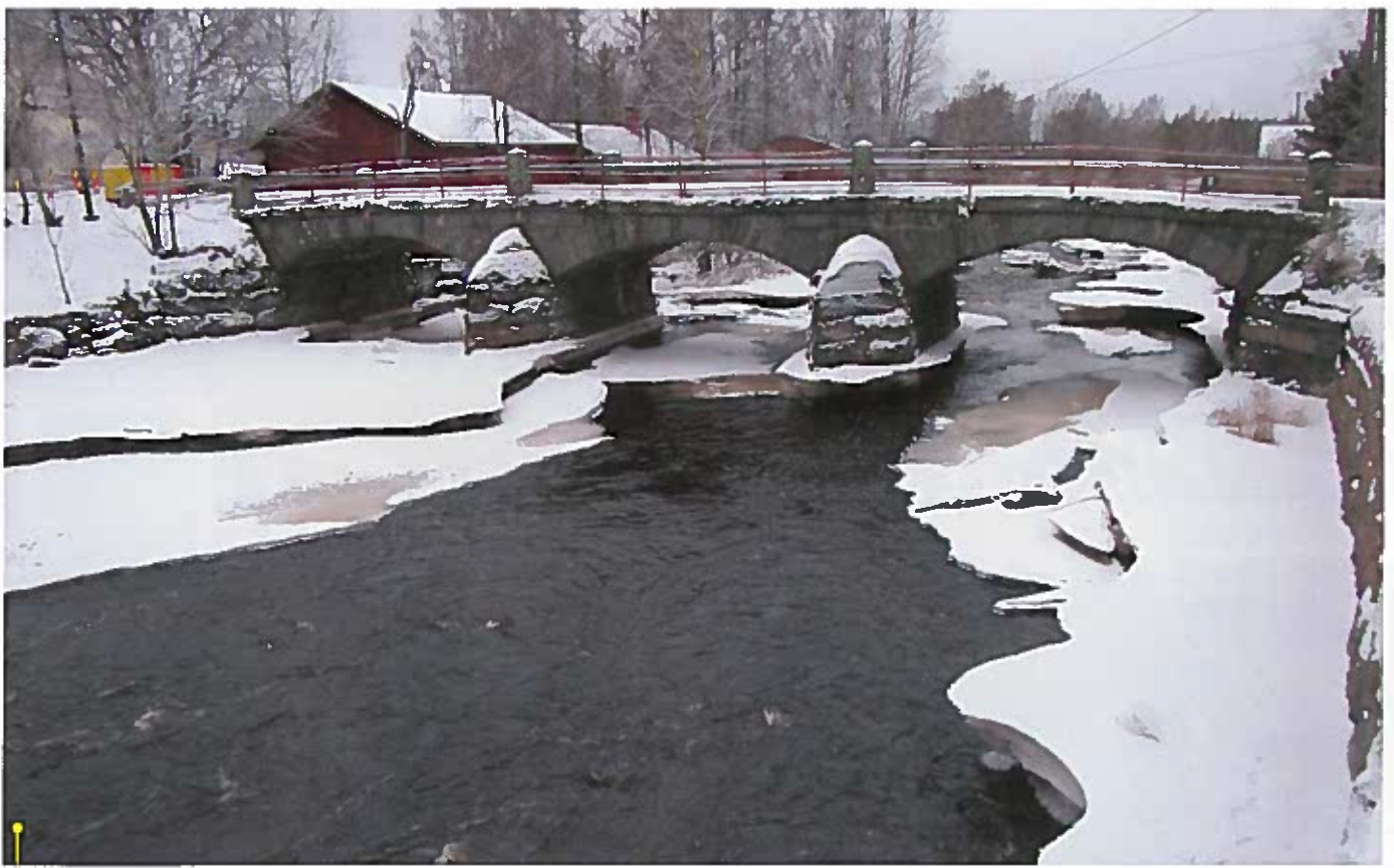
Kivisilta ennen purkua.
