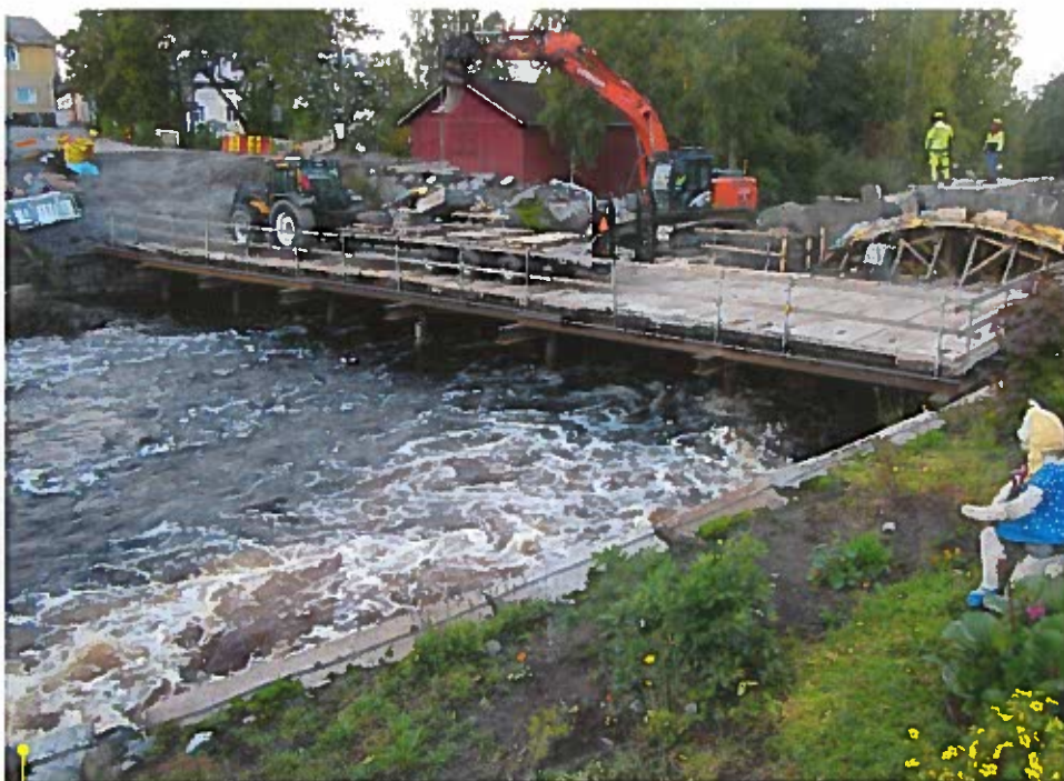
Kivisillan purku käynnissä.
