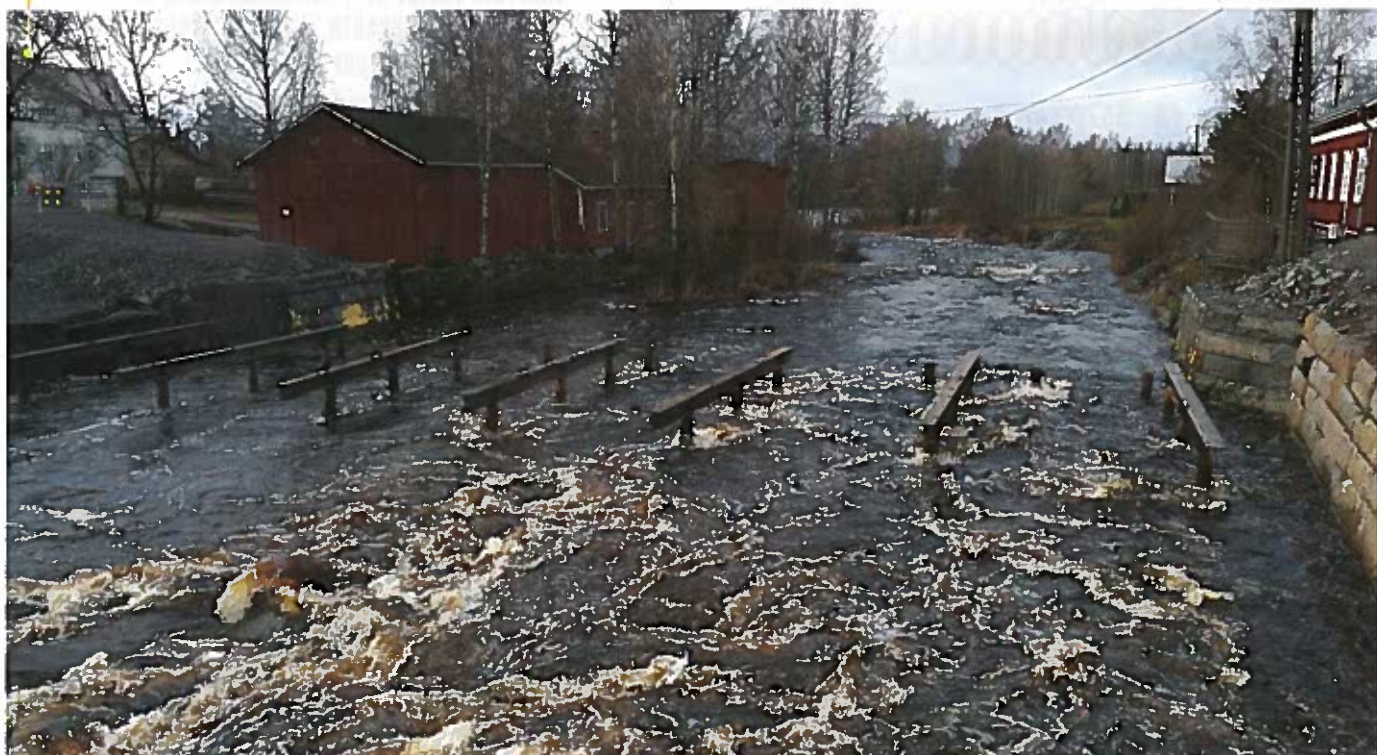
Kivisilta purkamisen jälkeen.
