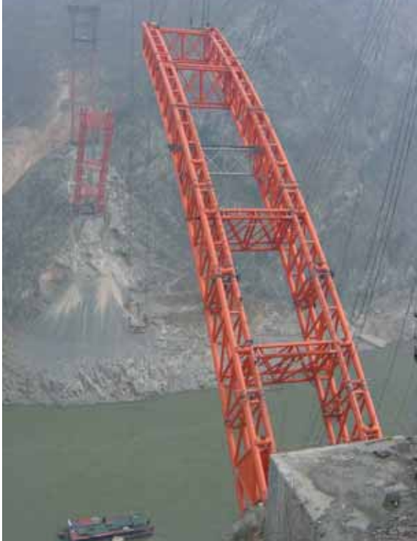
Teräsputkikaaret rakenteilla joen ylitse tilapäisten tukitornien ja köysien avulla.
