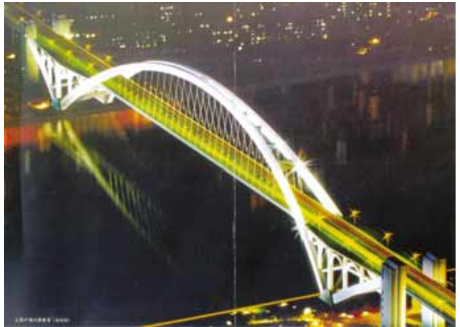
Kuvasovitelma Lupu-sillasta valmiina vuonna 2003.
