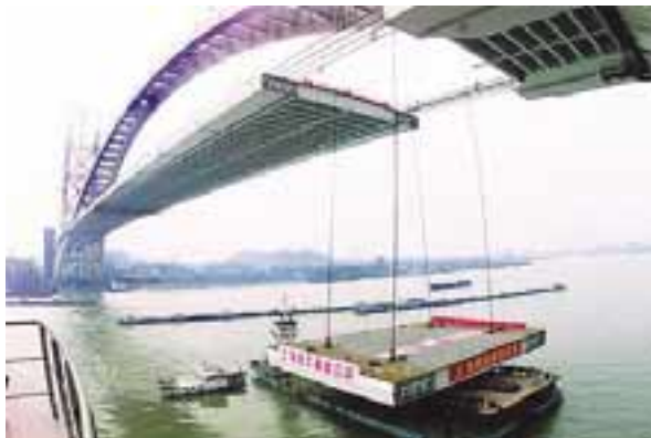
Viimeinen kansilohko nostetaan paikoilleen 02/2003.
