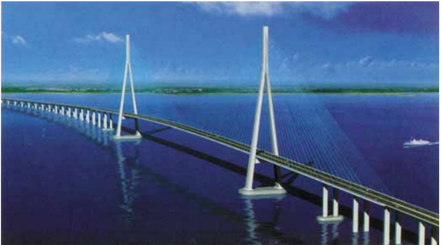
Sutongin silta, maailman pitkäjänteisin vinoköysisilta (1088 m) valmistuessaan v. 2008.
