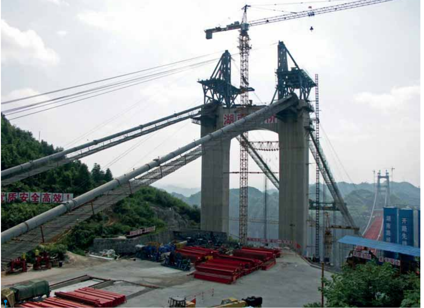
Sillan eteläpään lyhyt pyloni rakenteilla.
