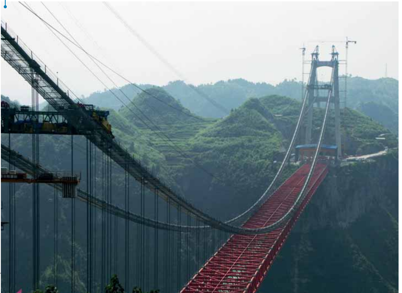
Teräsristikkokansi rakenteilla. Kuvassa taustalla sillan pohjoispään korkeampi pyloni.
