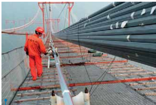
Riippuköyden osaköydet muotoillaan poikkileikkaukseltaan kuusikulmioiksi, jolloin ne saadaan sovitettua tiiviimmin yhteen.
