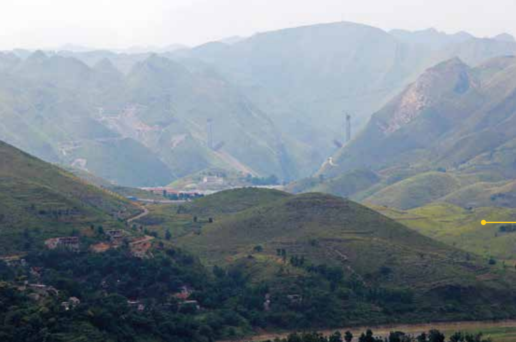
Yleiskuva siltapaikalta. Rakennustöiden alkuvaihe näkyy oikeanpuoleisen vuorenrinteen alaosassa.
