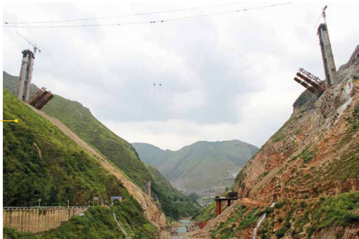
Sillan kaariosuuden pääty- pilarit ovat valmistumassa, terästukikaaren rakentaminen alkuvaiheessa.
