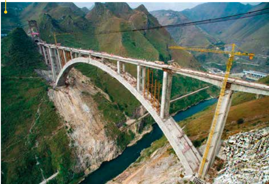
Kuvassa silta on rakennet- tu jo lähes valmiiksi. Sillan vasemmassa päädyssä näkyy tunneliaukko.
