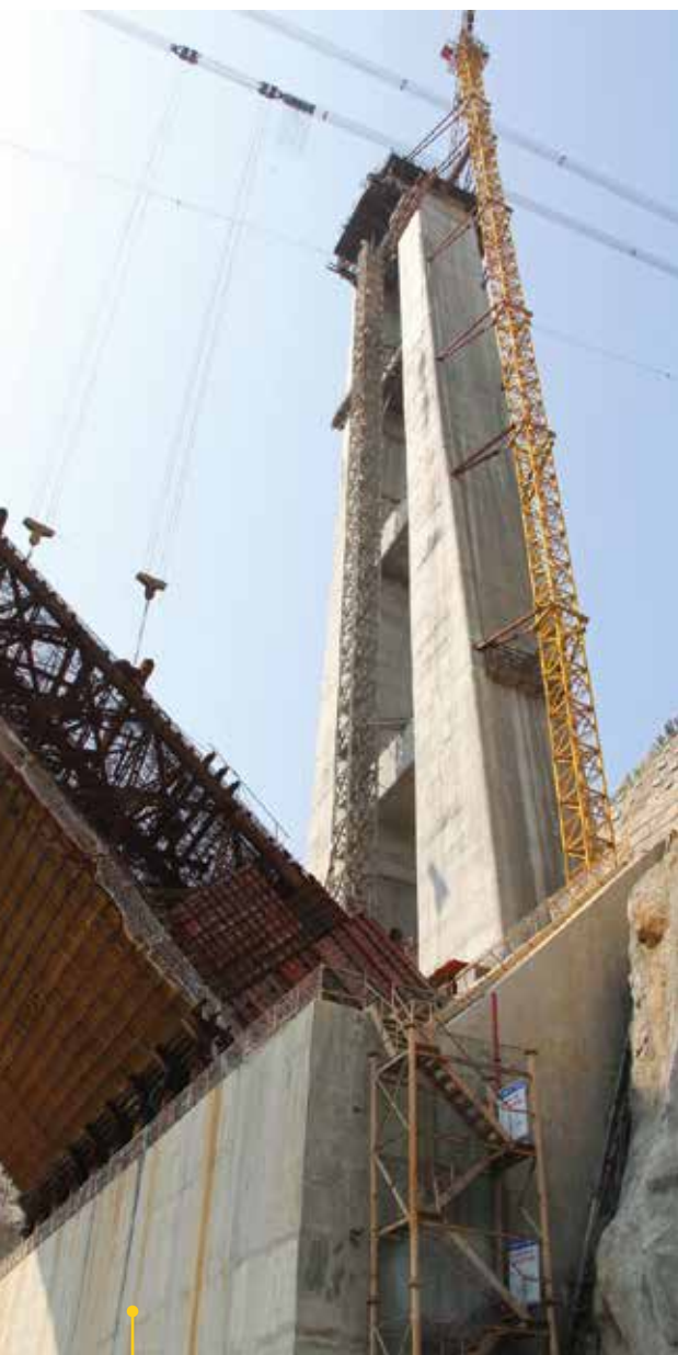
Detaljokuva sillan kaarirakenteen päädyn rakennusvaiheesta.
