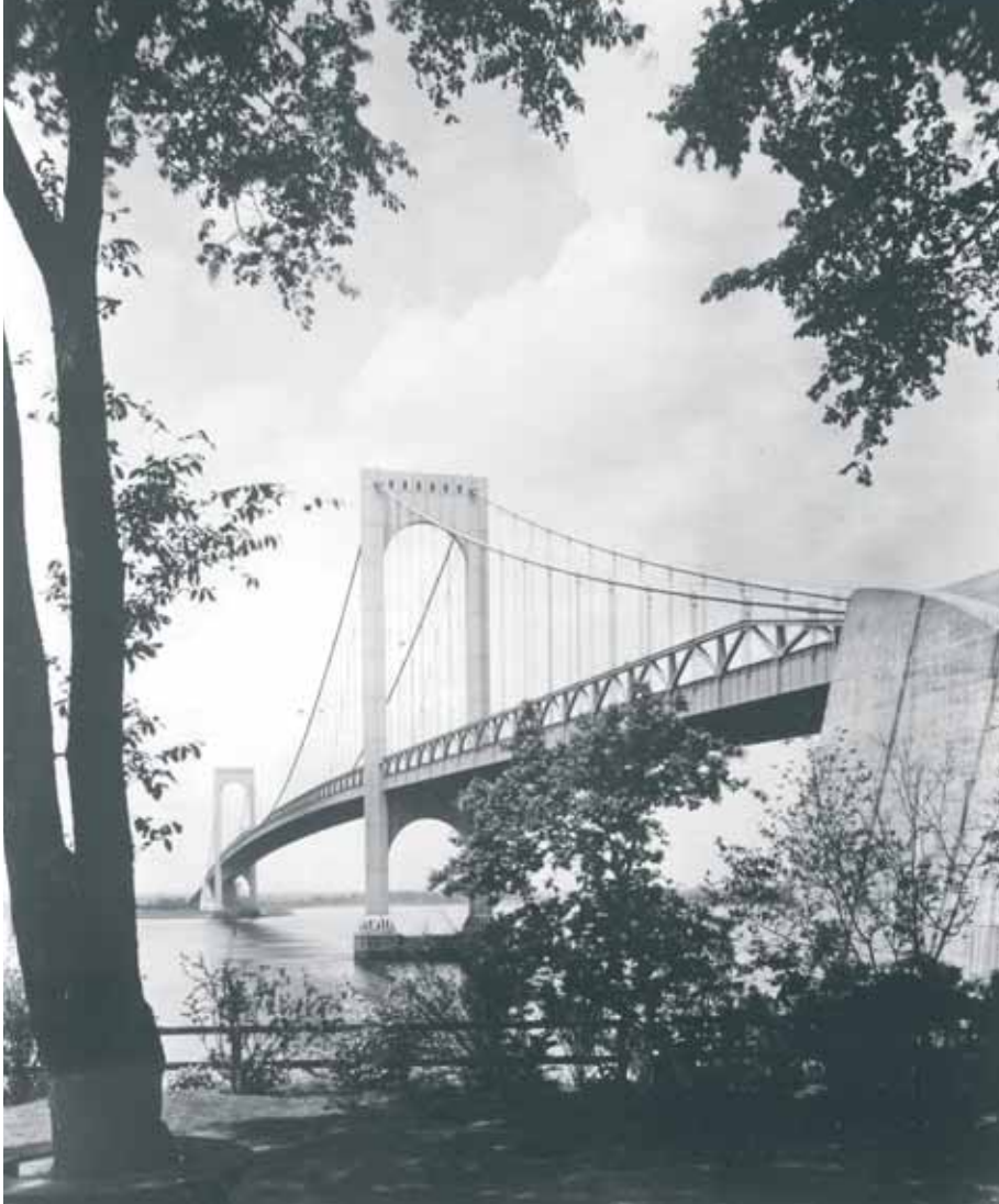
Vanhempi mustavalkoinen kuva, jossa näkyvät 1940-luvulla lisätyt teräsristikkopalkkijäkisteet.
