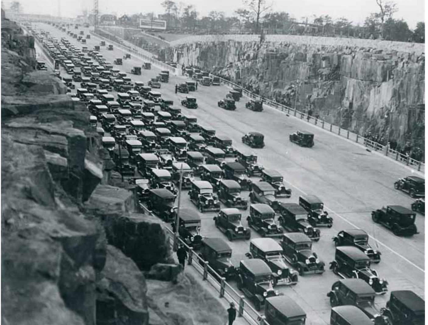
Noin 55 000 autoa odottamassa pääsyä sillalle ensimmäisenä liikennöintipäivänä lokakuussa 1931 [7].
