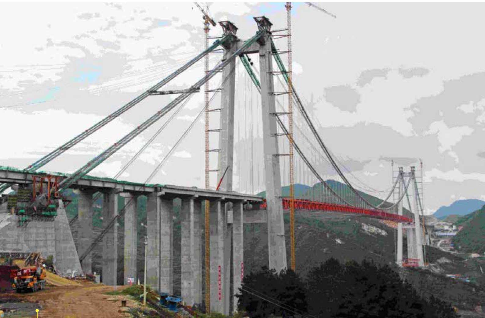
Silta lähes valmiina, riippuköysien apuköydet rakennettu, riippuköydet vielä rakentamatta.
