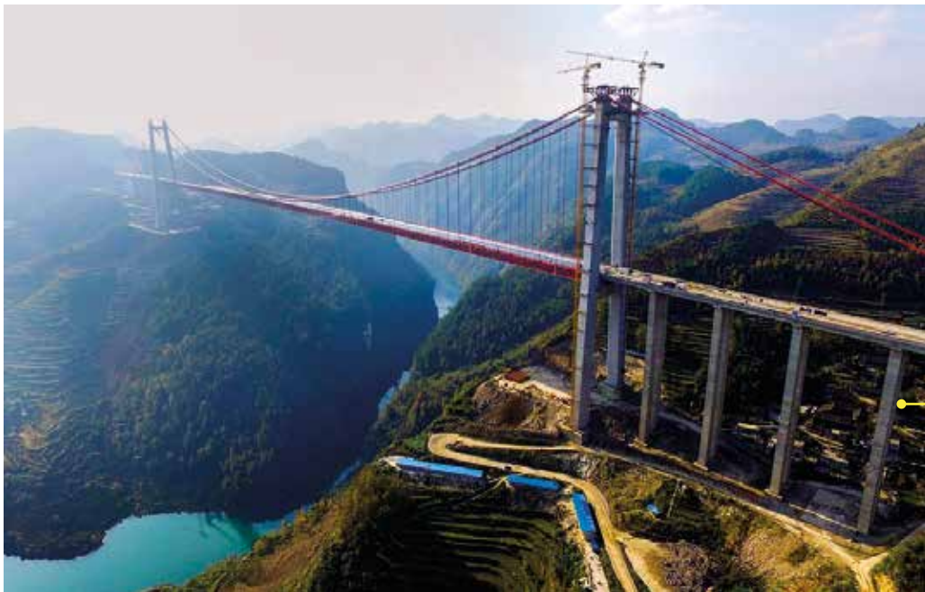
Silta lähes valmiina, riippuköysien apuköydet rakennettu, riippuköydet vielä rakentamatta.
