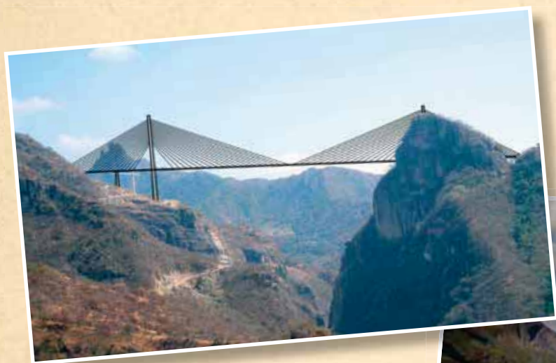
2011/1, Puente Bahuarte - korkea vinoköysisilta Meksikossa
