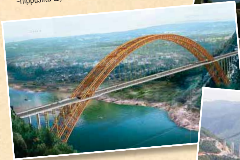
2006/4, Wushan Bridge - suuri teräskaaarisilta rakennettu Kiinassa
