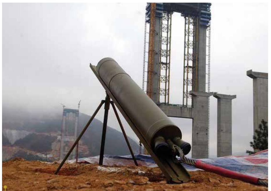
Kuvassa tykki, jolla rotkon reunalta ammuttiin pilottiköysi vastakkaiselle reunalle.
