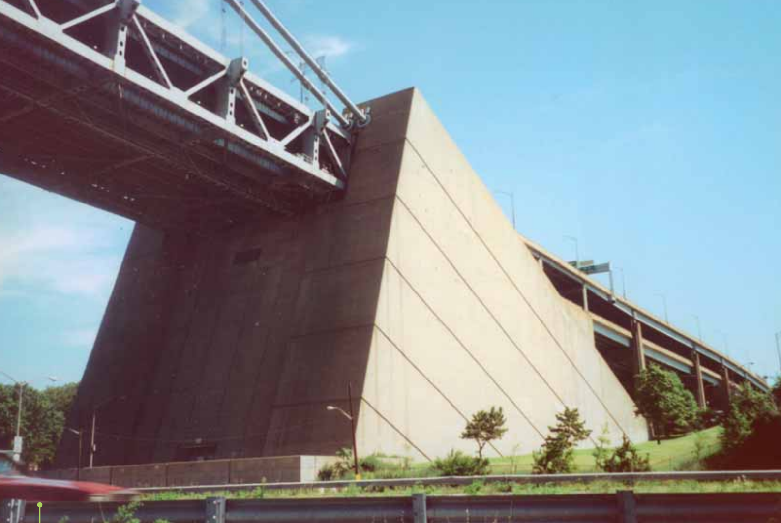
Riippuköysien betoniankkuri.
