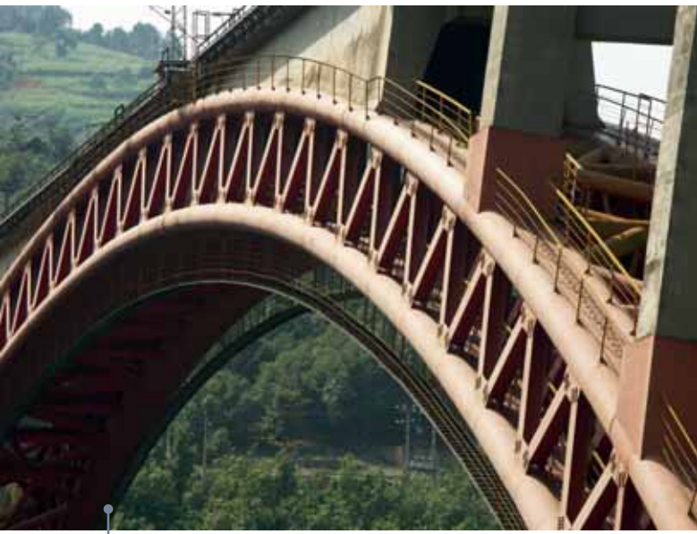
Teräskaarirakenteen kulmissa on neljä poikkileikkaukseltaan pyöreää onttoa teräsputkea, jotka täytettiin betonilla rakenteen jäykistämiseksi.
