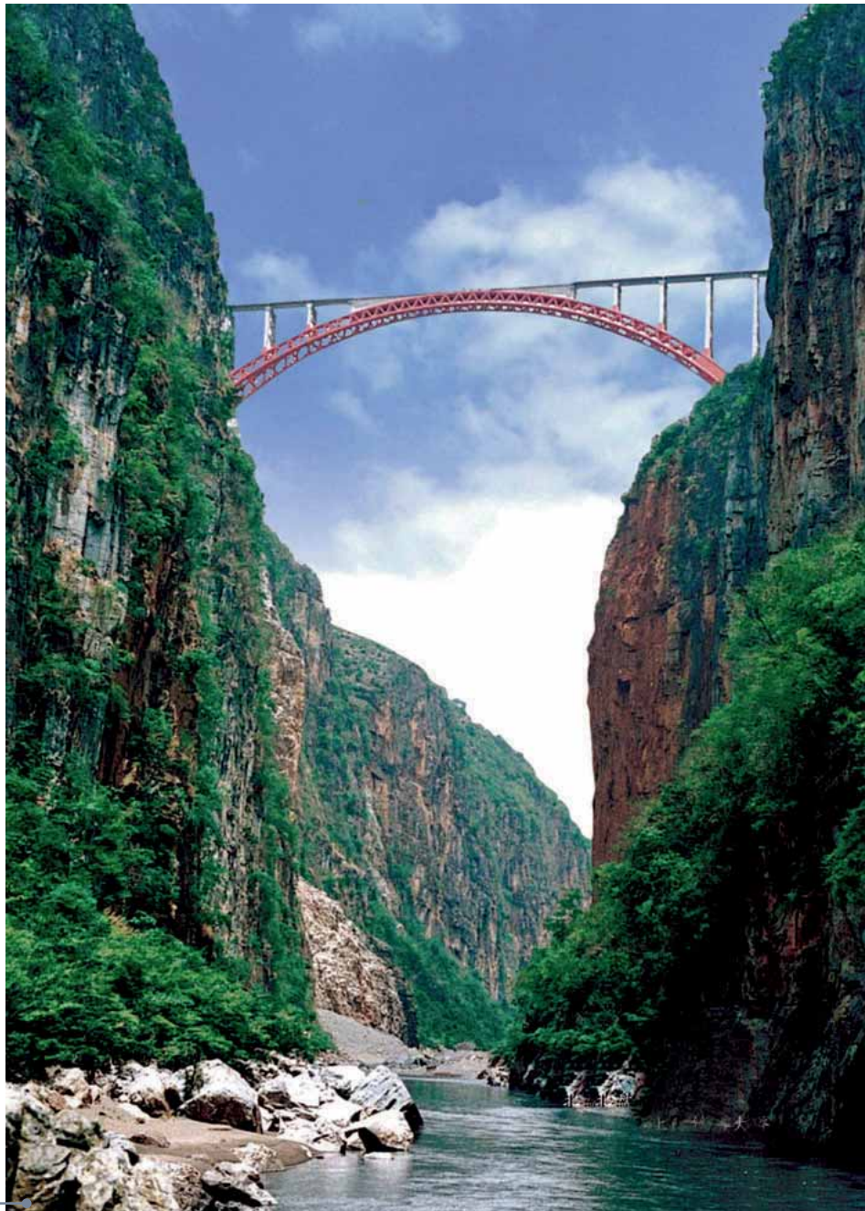
Teräskaarirakenteen kulmissa on neljä poikkileikkaukseltaan pyöreää onttoa teräsputkea, jotka täytettiin betonilla rakenteen jäykistämiseksi.
