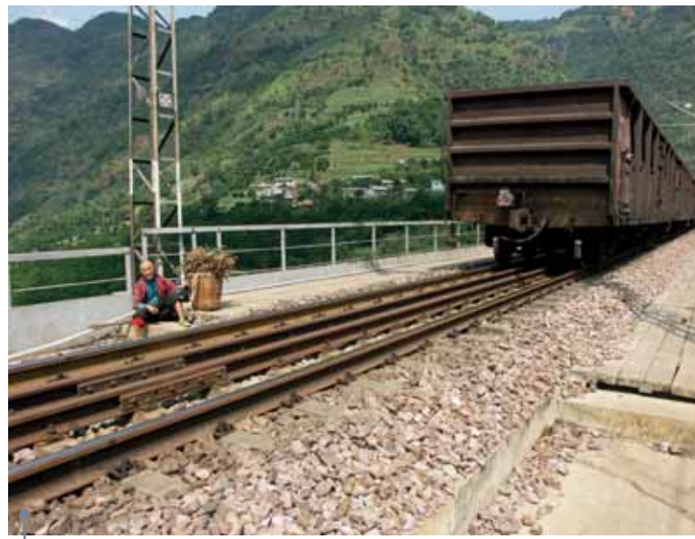
Kuvasta päätellen sillan voi ylittää yksi juna kerrallaan, huoltokaistat siltakannen reunoilla.
