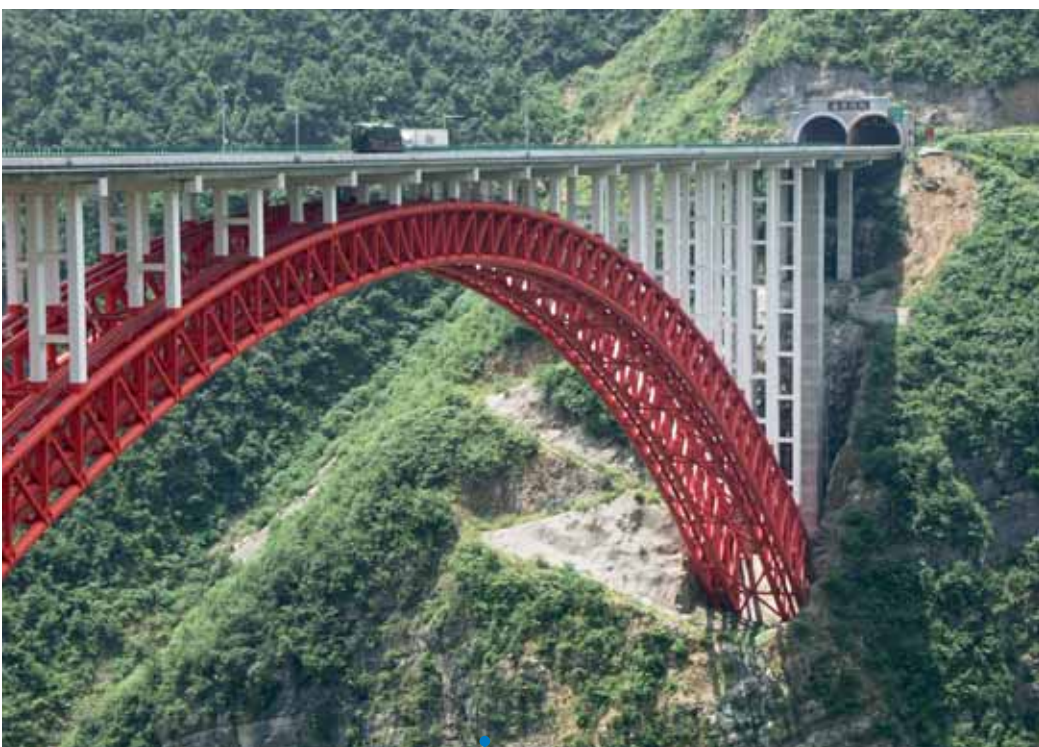
Kuvassa näkyy kummankin rinnakkaisen siltakaaren keskinäinen asema.
