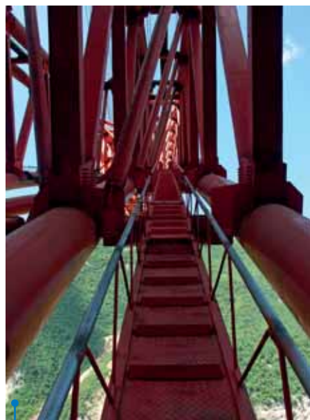
Kuva toisen siltakaaren kahden alimman teräsputken kohdalta.
