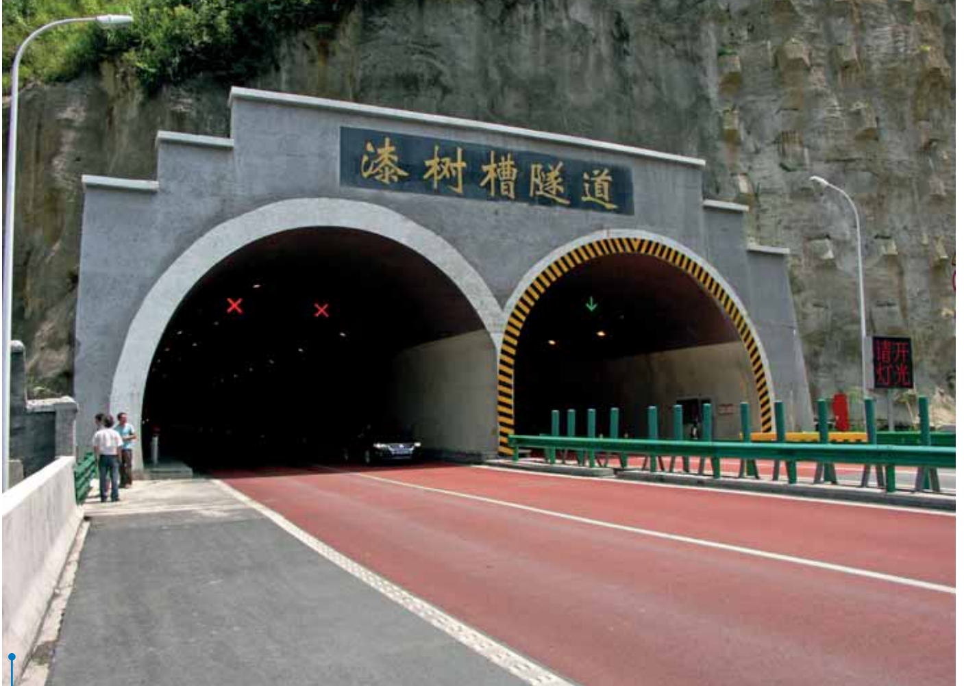
Sillan länsipään tunneliaukot.
