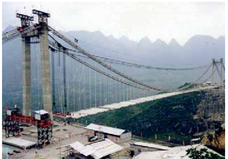
Sillan kansirakenteen betonielementtejä asennetaan paikoilleen.
