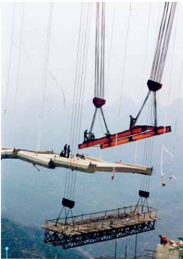
Ohutta siltakannen betonielementtiä nostetaan kansirakenteen tasolle.
