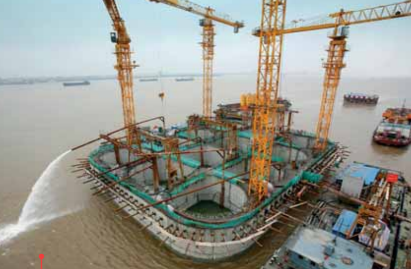
Keskipylonin perustus rakenteilla.
