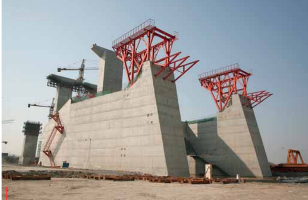
Riippuköysien eteläinen massiiviankkuri rakenteilla.
