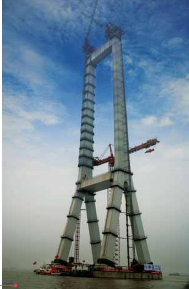
Keskipyloni rakenteilla.
