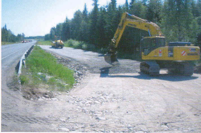
Leipiöojan sillan kiertotie.
