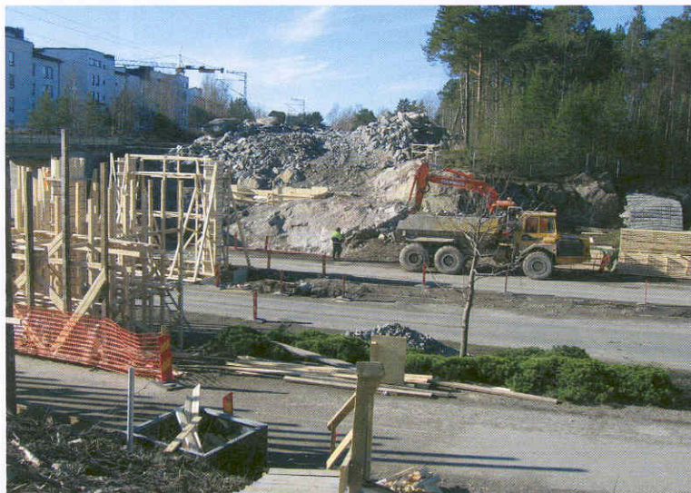
Vilkasliikenteisen Luoteisväylän ylittävän Leikarinmäen risteys sillan maatuet perustetaan suoraan kallioleikkaukseen.
