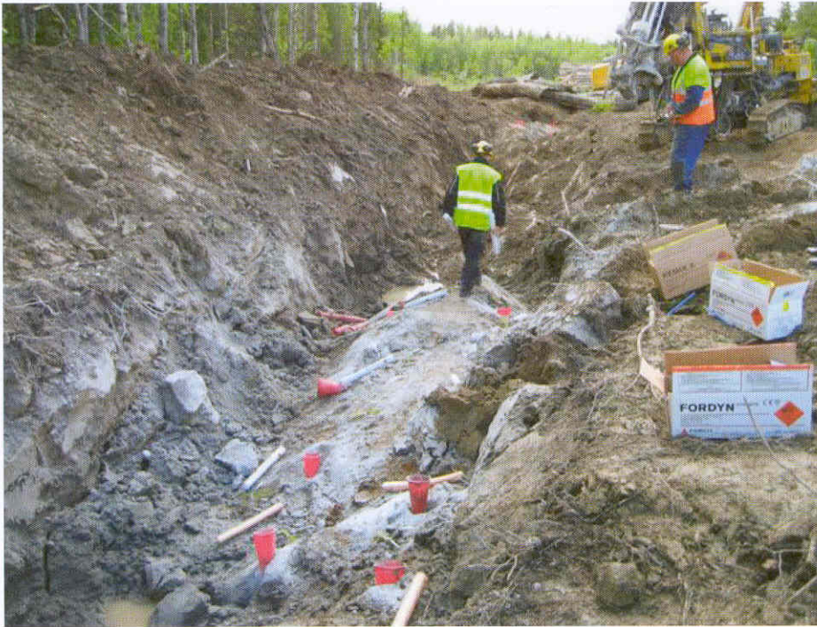
Kallion louhintaa putkilinjalla.
