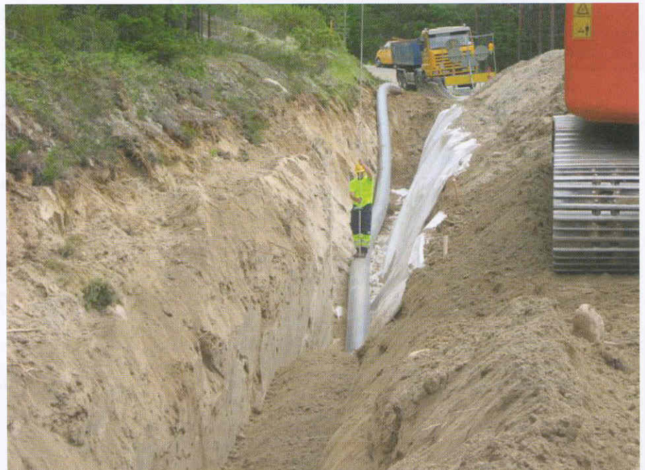
Konsultoinnin mittaaja Tauno Paakkannen mittaamassa putken sijaintia.
