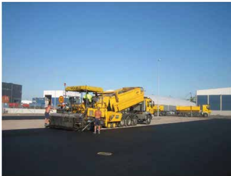
Asfaltointia Kotkan satamassa.
