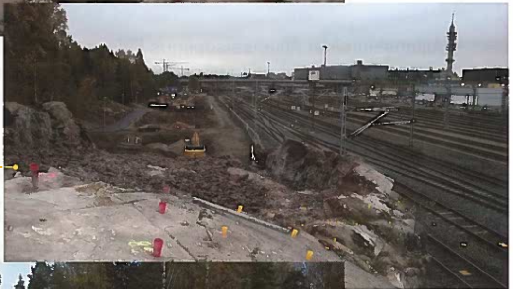
Louhinnat etenevät aikataulussa.
