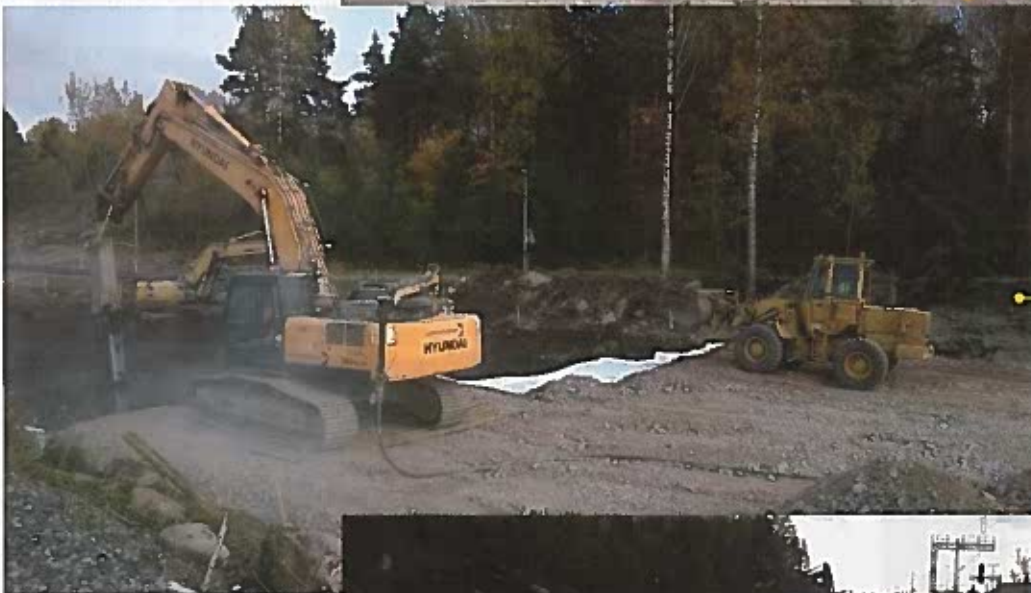
Massastabilointi ja painopenkereen teko.
