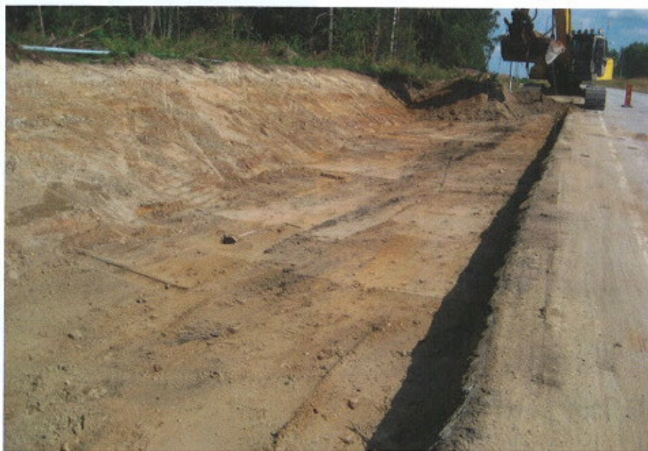
Maanleikkausta tien leventämiseksi valtatiellä 6.
