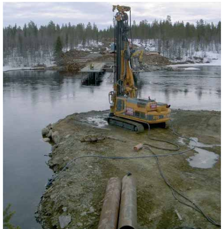
Pohjoismaiden suurimmat Porapaalut 813 mm Sodankylässä Siltatyömaalla
