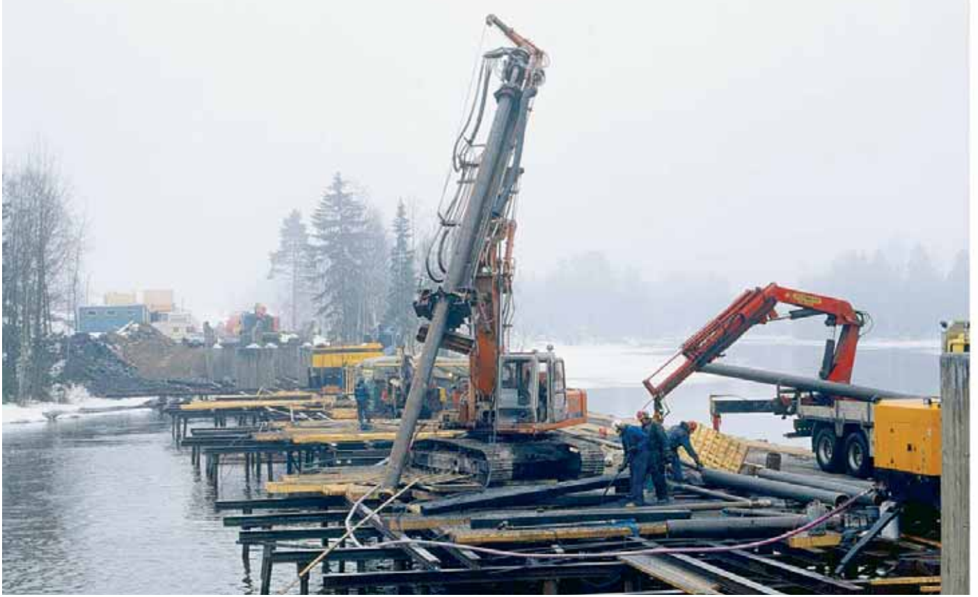
Porauskalustollamme porattavat paaluhalkaisijat 139,7 - 813,0 mm.
