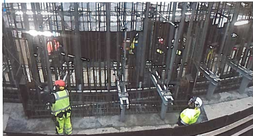
Seinäuloke missä sijaitsevat vaaka-ankkureiden päät.
