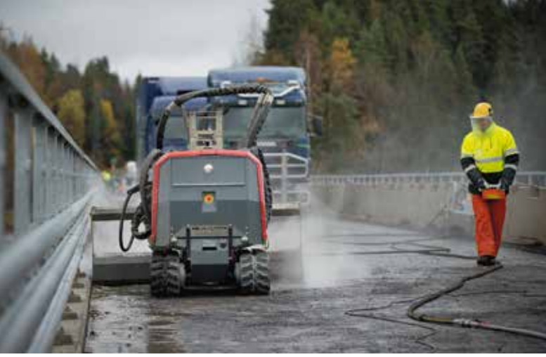
Siltatyömailla käytetään apuna vesipiikkausrobotteja.
