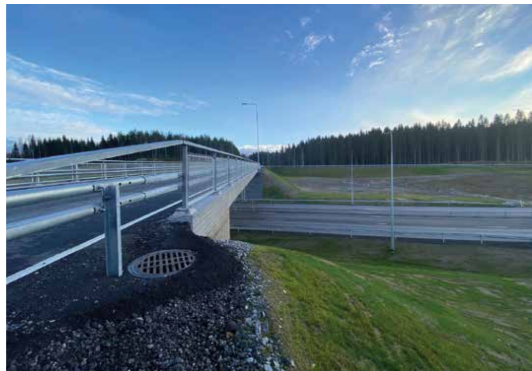
Valmista baanaa Huuhanahon eritasoliittymässä.
