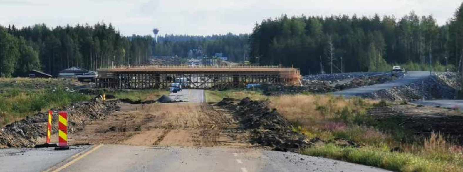
Näkymä rakenteilla olevaan Hatsolan eritasoliittymään.
