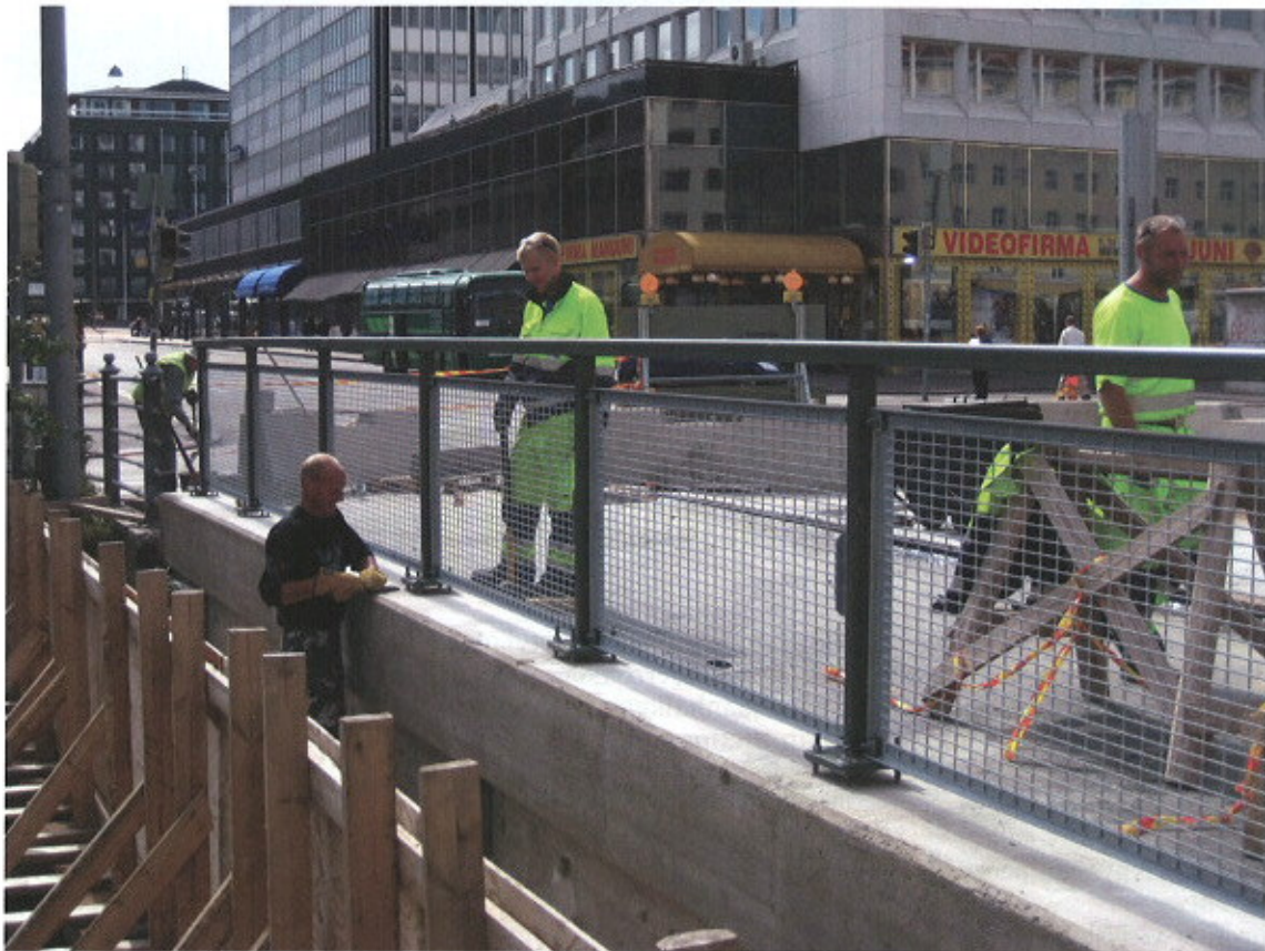
Fredrikinkadun sillankorjaus, Helsinki, kaiteiden asennus käynnissä.
