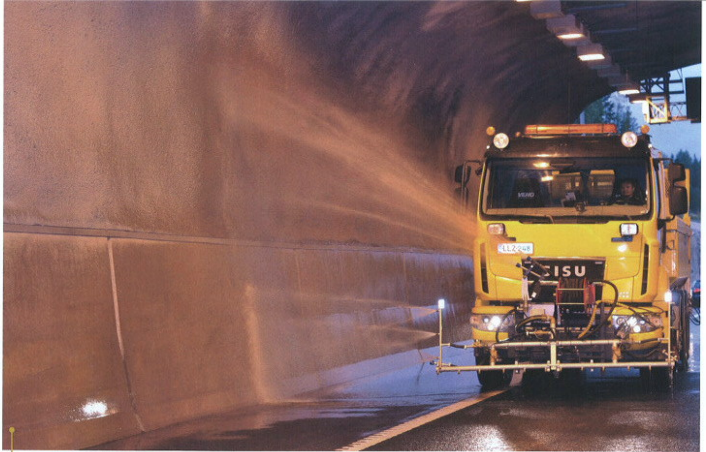
Tunnelin syyspesua Hepomäessä.
