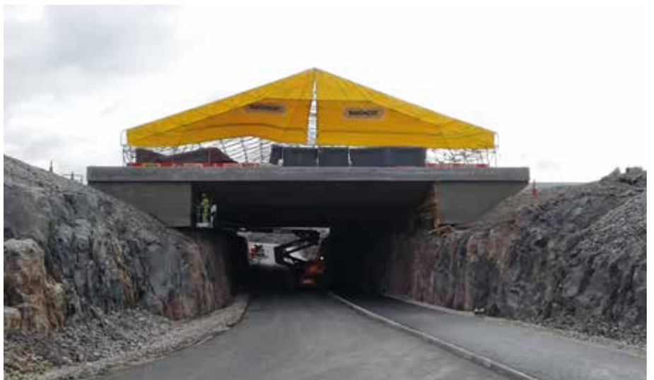
Valettu silta huoltotieltä katsottuna. Muotin ja sääsuojan purku käynnissä.
