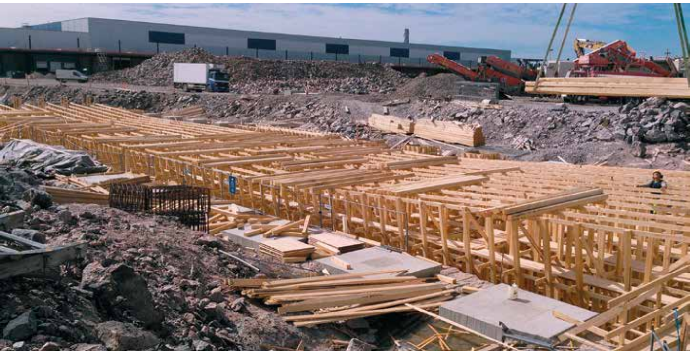
Sillan telineen rakentamista.
