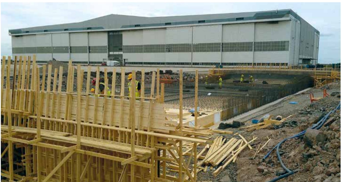
Sillan raudoitus käynnissä.
