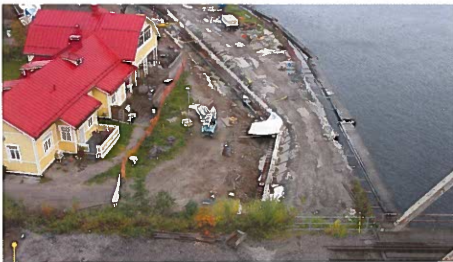
Rantalan tukimuuri; porapaaluja 3000 m. Kuva otettu uudelta sillalta.
