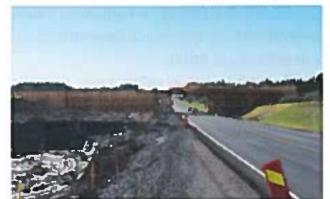
Humikkalan pohjavesialueelle rakennetaan Myllymäen risteyssilta.
