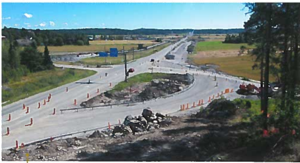
Mietoisten liittymäalueen kiertotiejärjestelyt ovat valmiit, vanhan valtatieen purku voidaan aloittaa.
