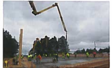
Isomäen sillan betonointi käynnissä.
