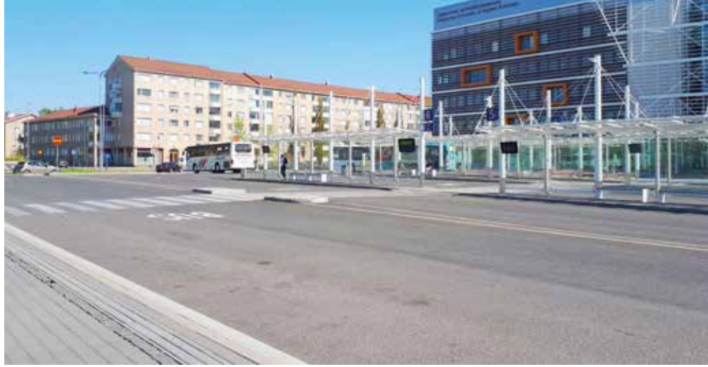
Laitureille rakennettiin erilliset katosrakenteet.
