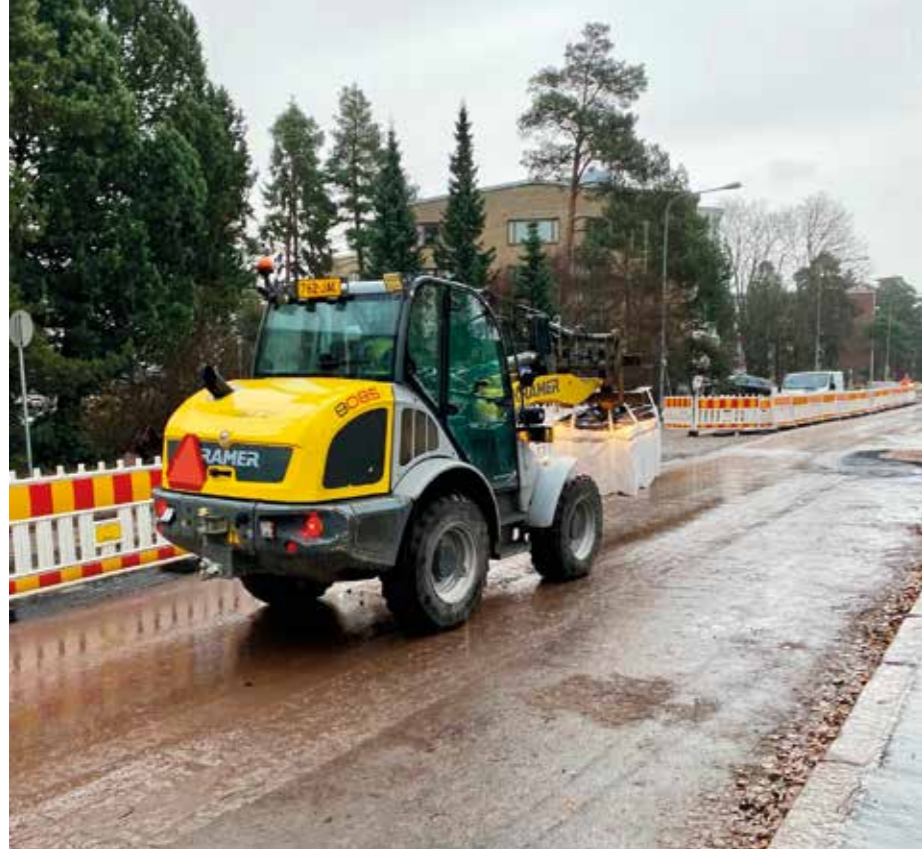
Sähköinen pyöräkuormaaja Kulosaaren pilottityömaalla.
