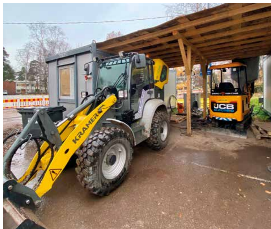
Kulosaaren urakan täyssähköiset pyöräkuormaaja ja minikaivuri latauksessa.
