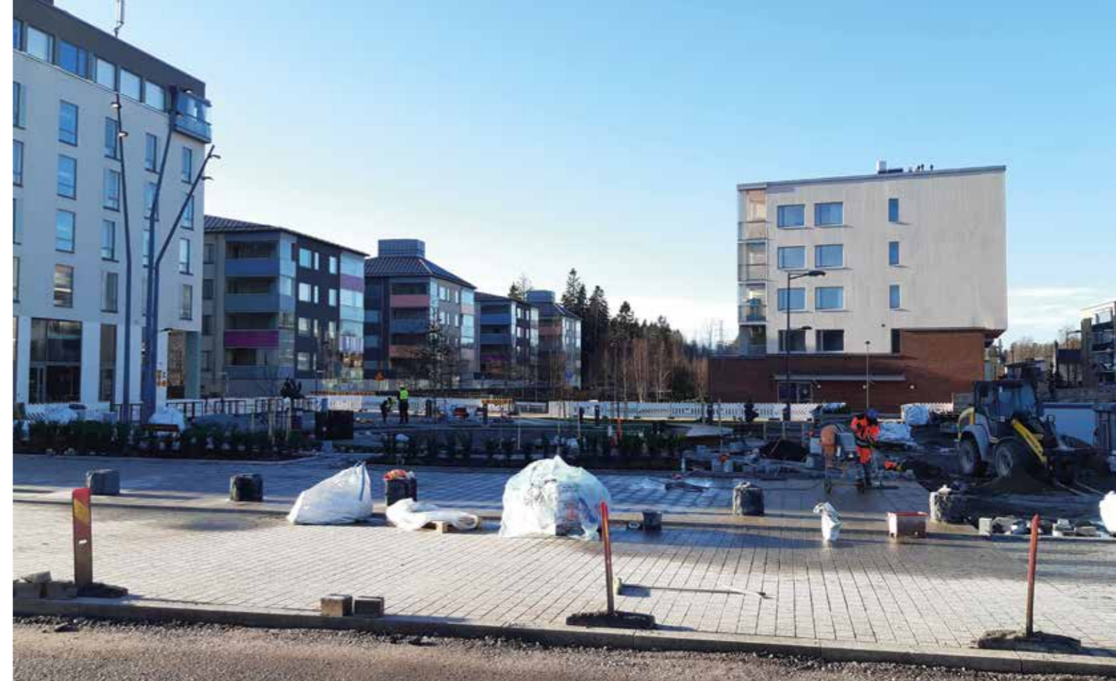
Espoon Suurpellossa oleva Lukutorin päästötön työmaa-työmaa -pilotti valmistuu marraskuun 2020 aikana.
