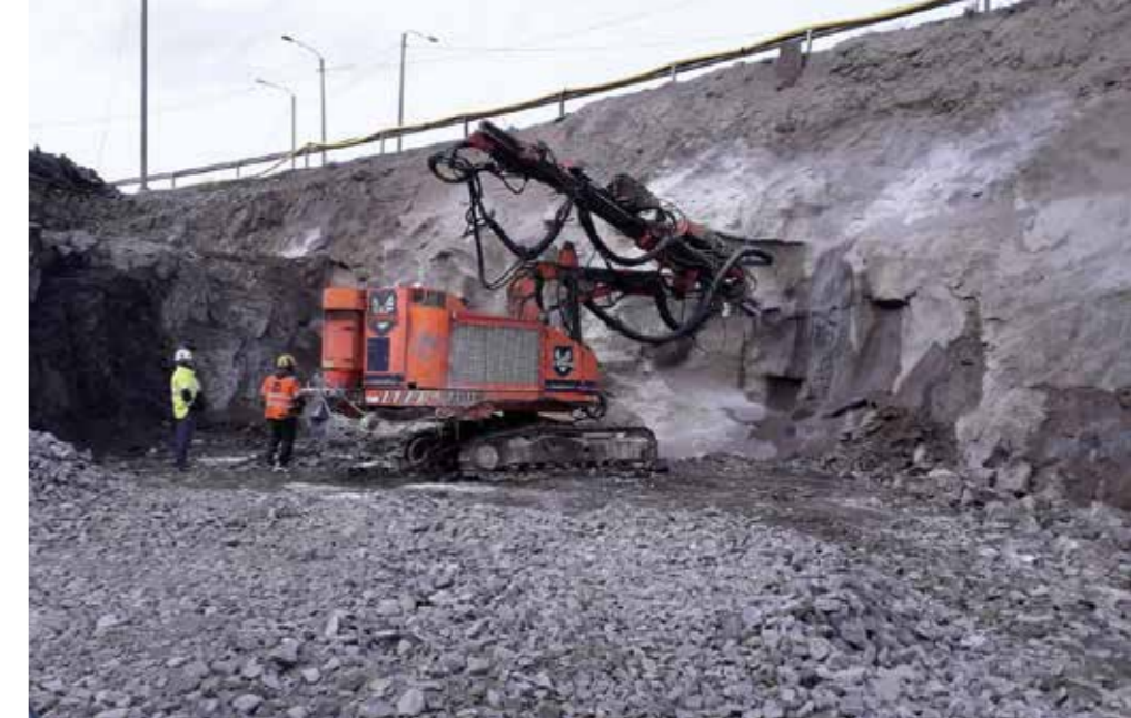
Kuva 2. Kalliopulteille porataan reikiä.
