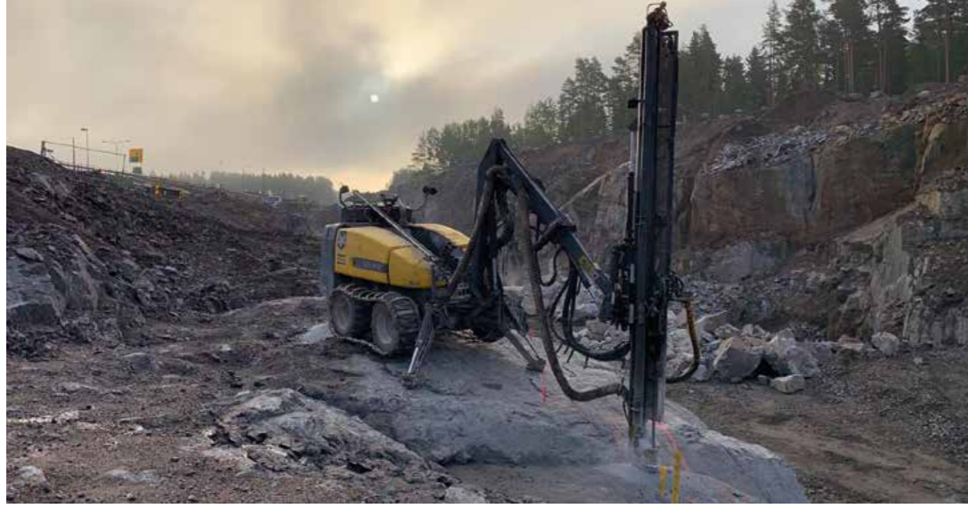
Kuva 7. Sterkman käyttää kiilalouhinnoissa 35-127 mm reikää.
