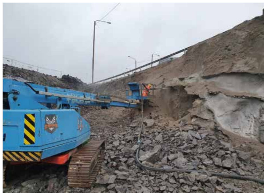
Kuva 1. Vahva tela-alustainen nostin on kätevä ruiskutustöissä.
