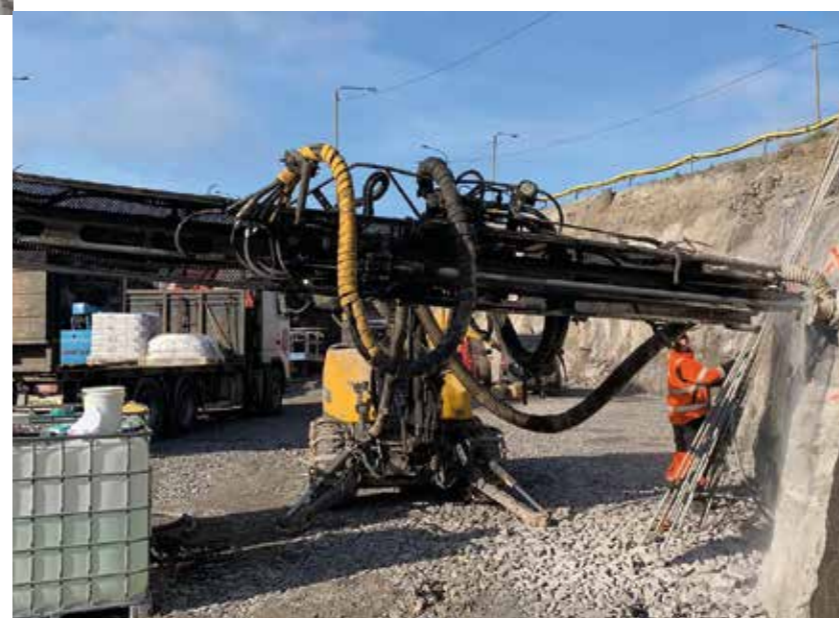
Kuva 4. Kallionlujituspulttien porausta.
