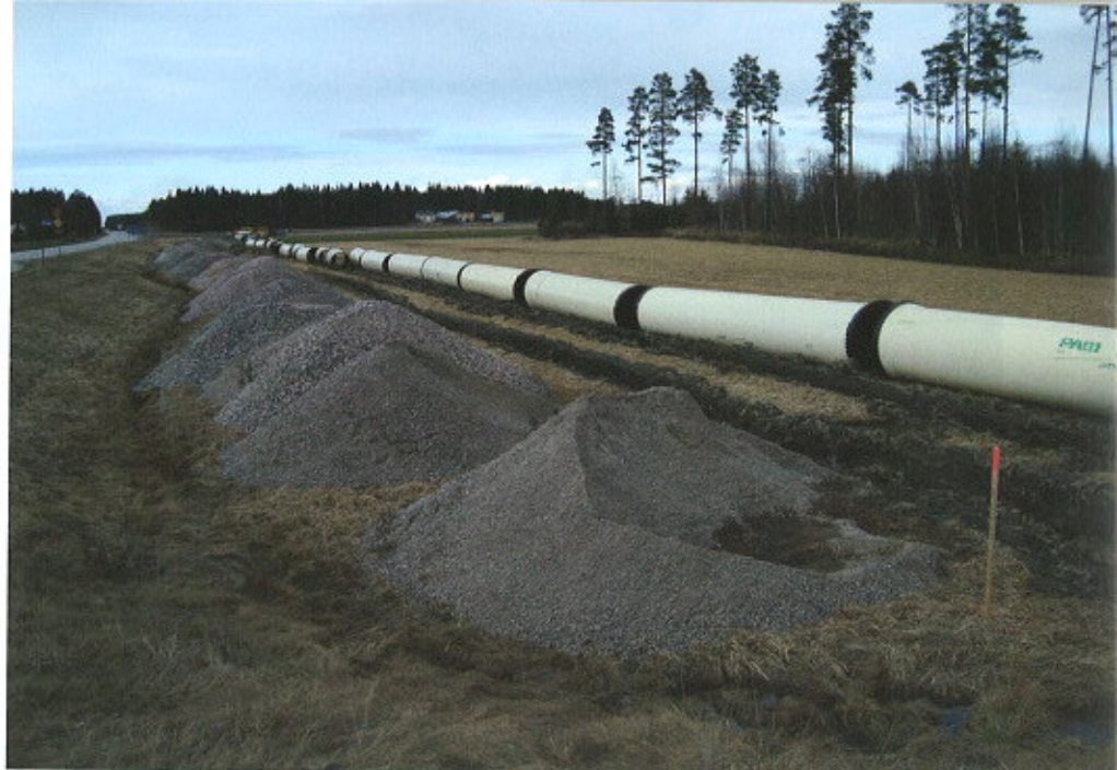
Pehmeikköalueille ajettiin putket talven aikana. Kuvassa PUX-pinnoitettuja putkia.
