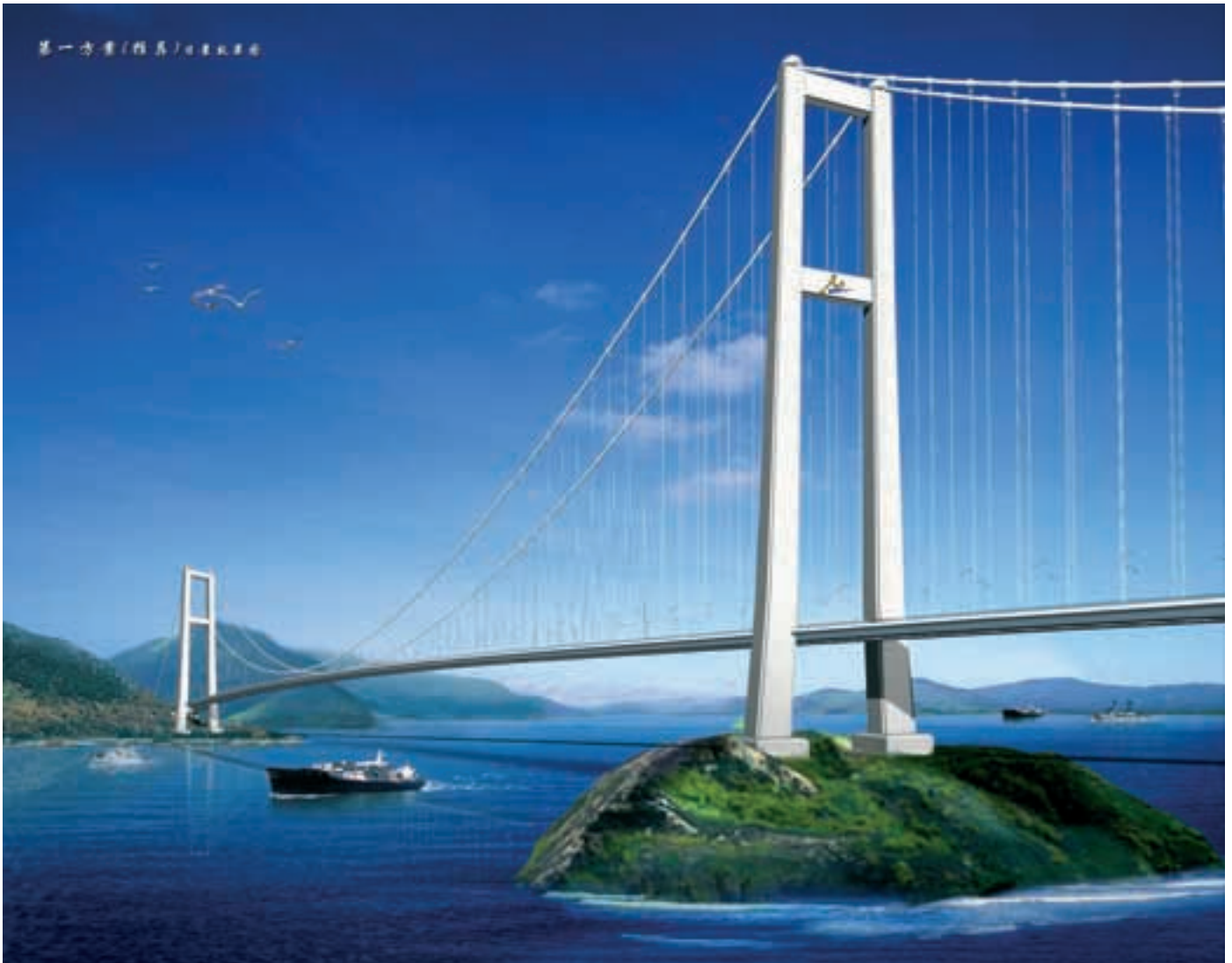
Kuvasovitelma Xihoumenin riippusillasta, joka valmistuessaan vuoden 2008 lopulla tulee olemaan maailman 2. pitkäjänteisin silta. Kuvassa näkyvät sillan molemmat pylonit. Riiputettu sivujänne (578 m) kuvassa oikealla.
