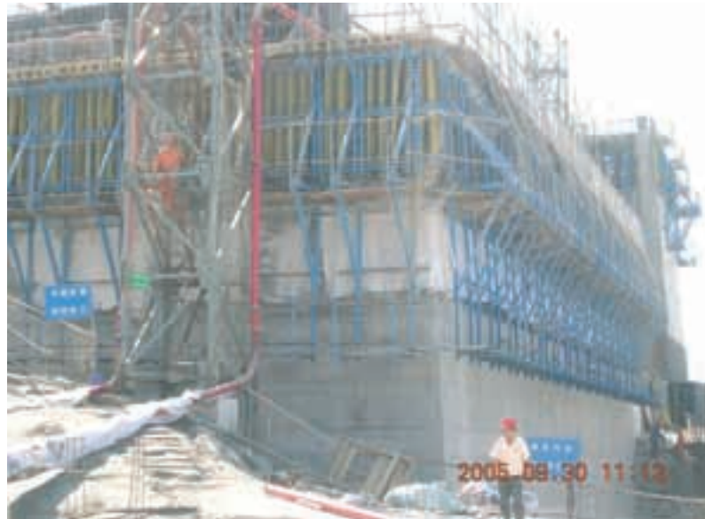
Pohjoisankkuri rakenteilla syyskuussa 2005.
