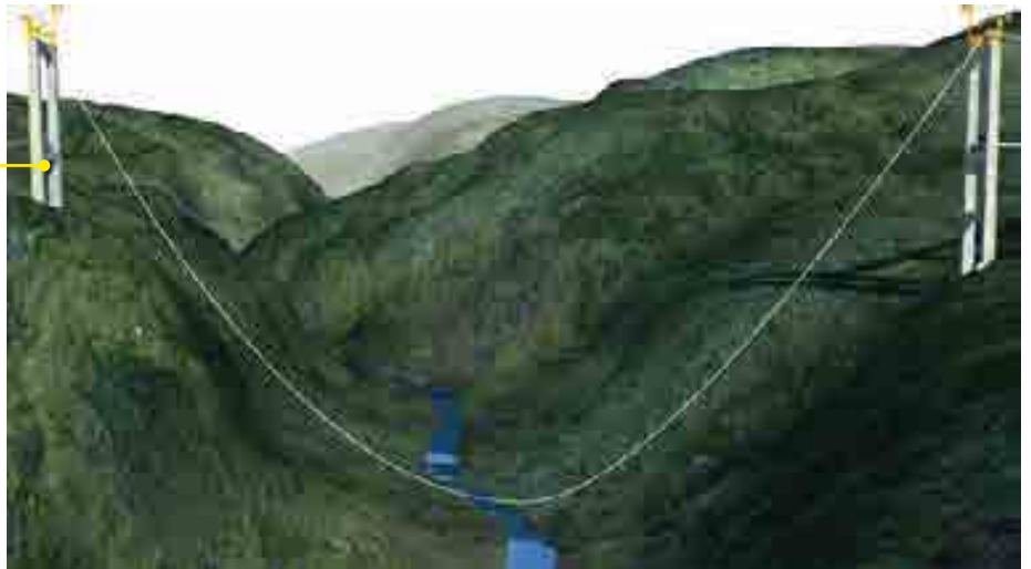
Detaljikuva pylonien välisestä pilot-tiköydestä rakennustöiden alkuvai-heessa.
