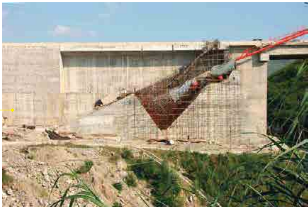
Detaljikuva sillan riippuköysien pääteankkurista rakennusvaiheen aikana.
