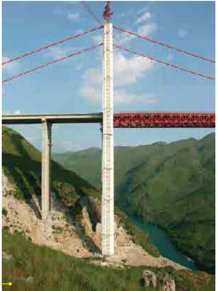
Lähikuva sillan pylonista ja kansirakenteesta sivul-tapäin katsottuna. Siltakannen ristikkopalkkiosuus sijaitsee vain pääjännevälin osuudella. Sen jatkeena on kummassakin päädyssä toisentyyppinen kansirakenne.
