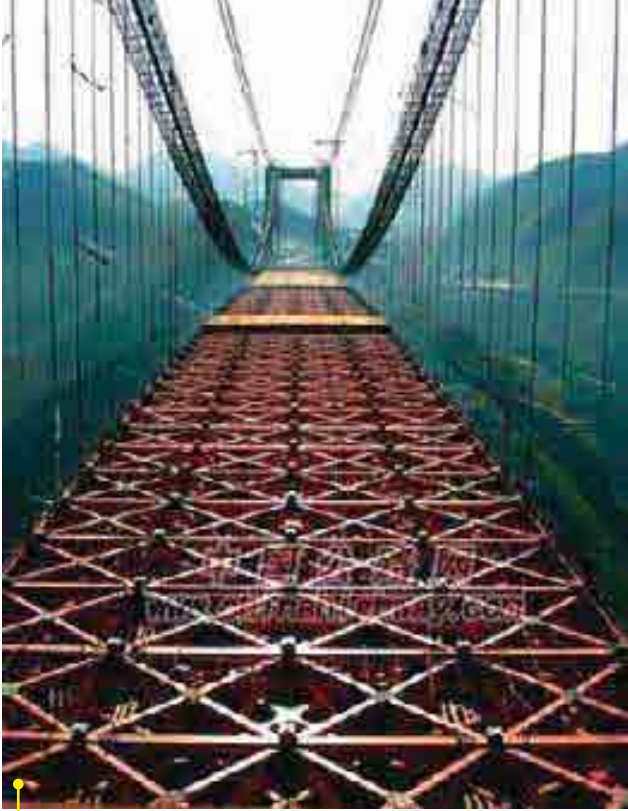
Detaljikuva sillan kansirakenteen ristikkopalkiston yläpinnasta rakennusvaiheen aikana.
