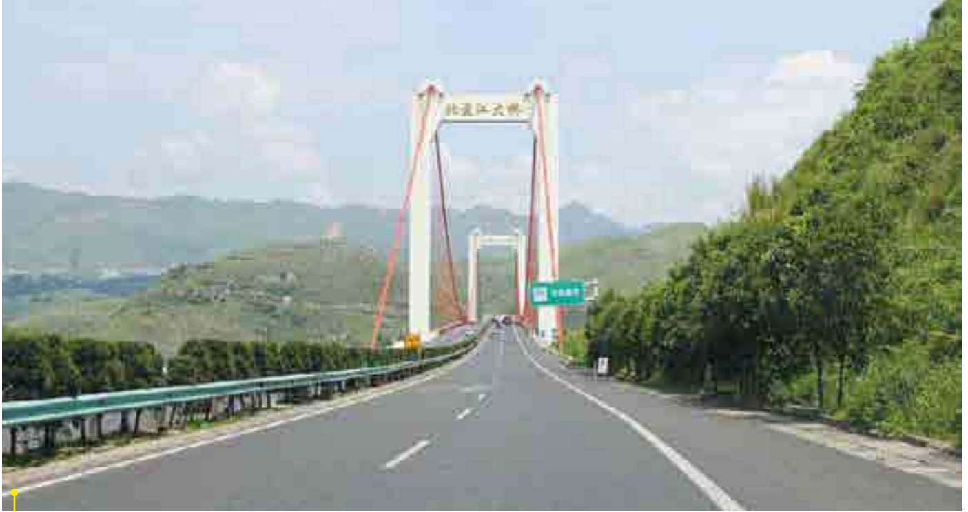
Kuvasta ilmenee, että siltaa pitkin kulkevalla maantiellä on 2 ajorataa kumpaankin suuntaan, kummallakin 2 ajokaistaa, molemmat huoltokaistat ajoratojen ulkoreunoilla.
