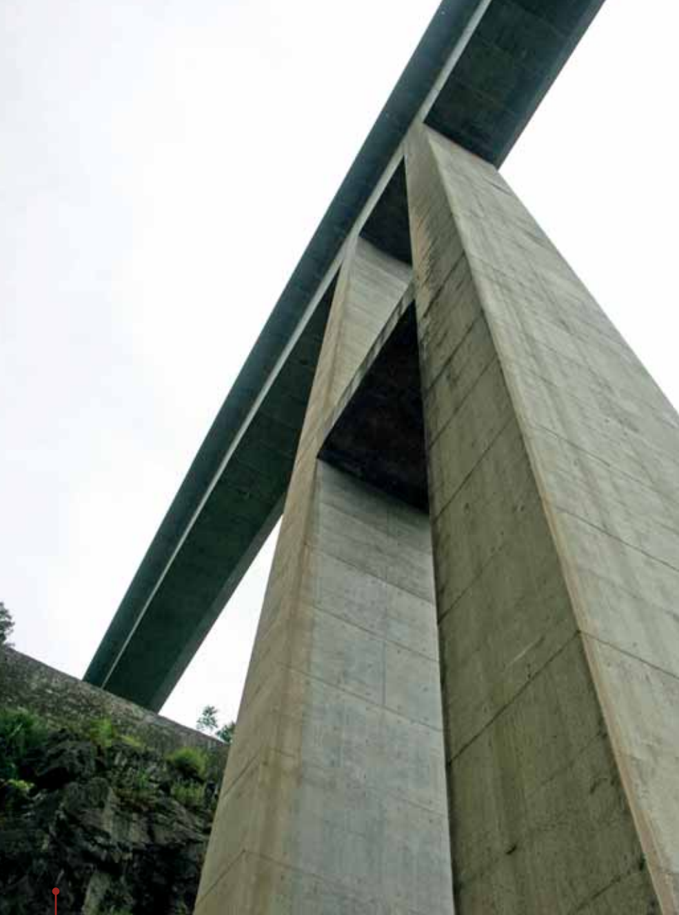
Sillan korkeampi välituki ja kansirakenne alhaalta ylöspäin katsottuna.
