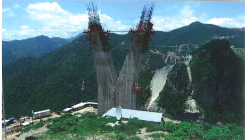
Durangon puoleisen pylonin alaosa rakenteilla (tuki 5). Pylonin korkeus on 169 m, juurella tilapäinen toimistorakennus. Kuva: Grupo Triada/SCT
