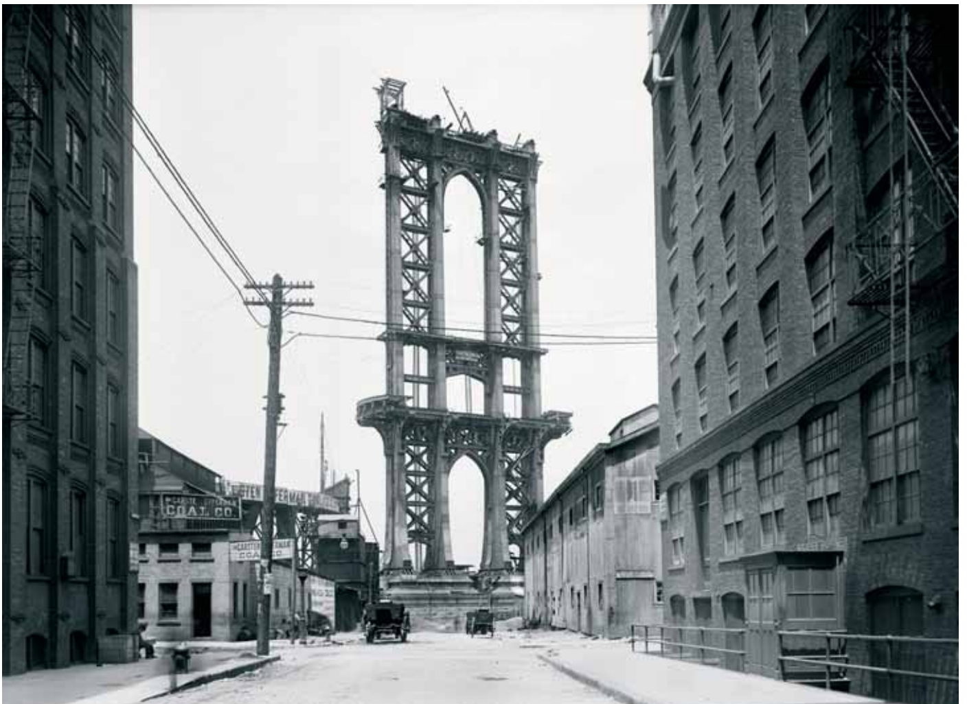
Vanha kuva vuodelta 1908, Brooklynin puoleinen pyloni valmiina odottamassa riippuköysien asentamista. Kuvan on ottanut valokuvaaja Eugene de Salignac ja kuvateksti kuuluu: "Manhattan Bridge, from Washington Street looking west, Brooklyn, June 5, 1908". Kuva: New York City Municipal Archives
