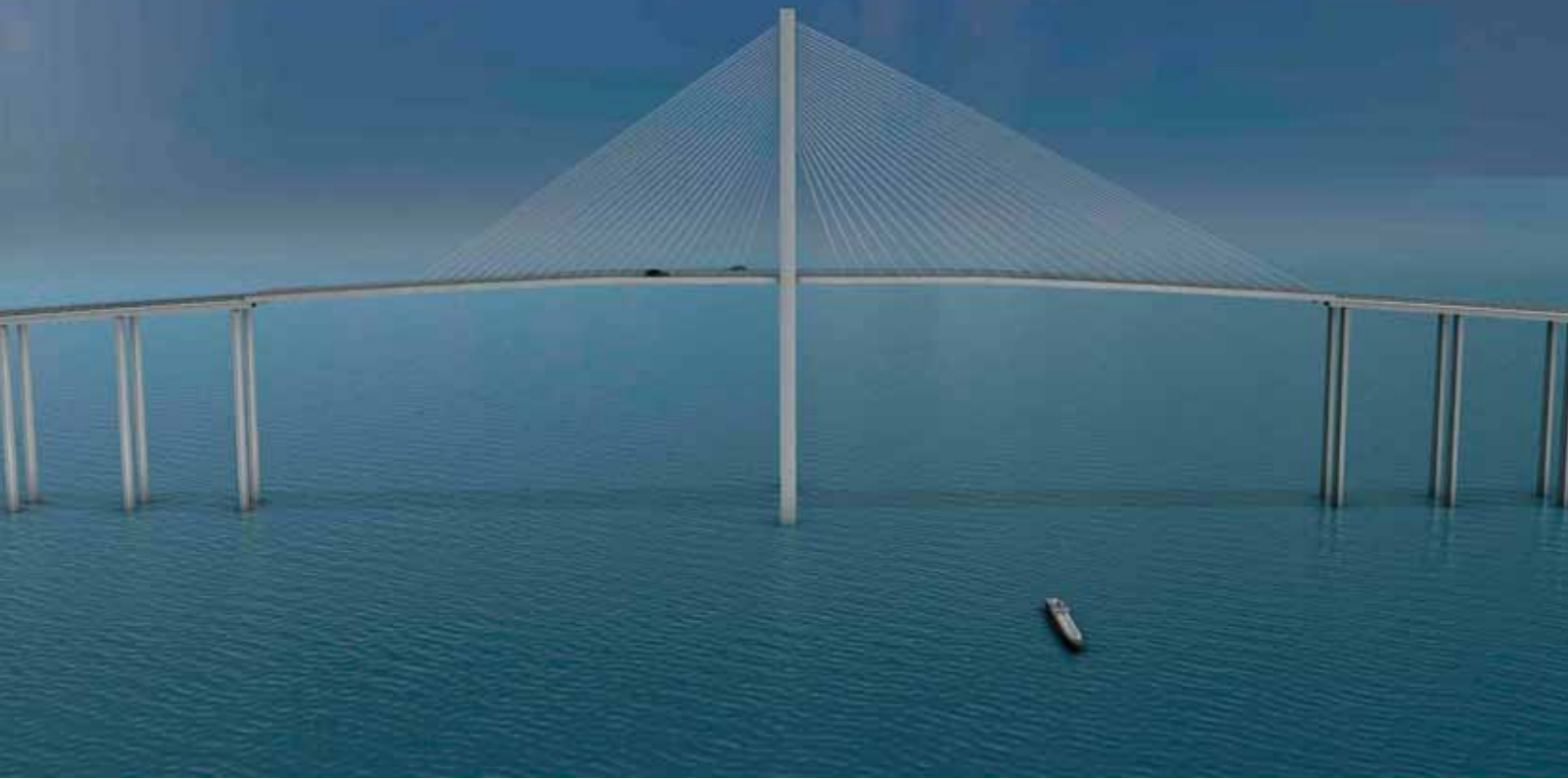
Kuvasovitelma 1-pylonisesta vinoköysisillasta sivultapäin katsottuna.
