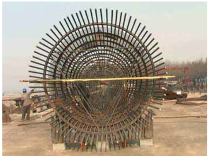
Kaivinpaalun raudoituselementti.
