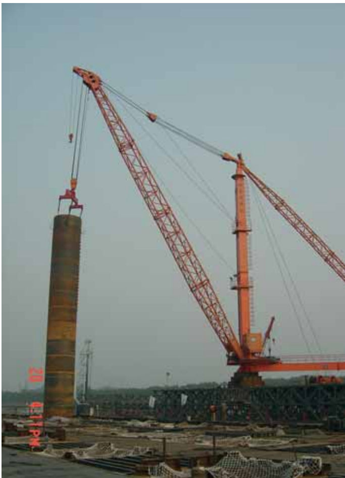
Kaivinpaalun teräsvaiippa nosturilautan 120 tonnin nosturin nokassa.
